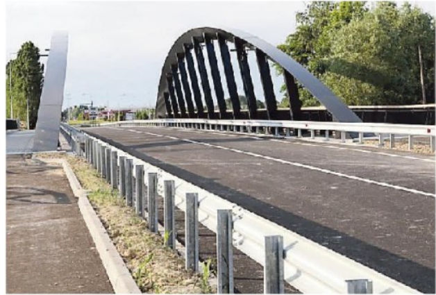
Il cavalcavia del Terraglio Est
