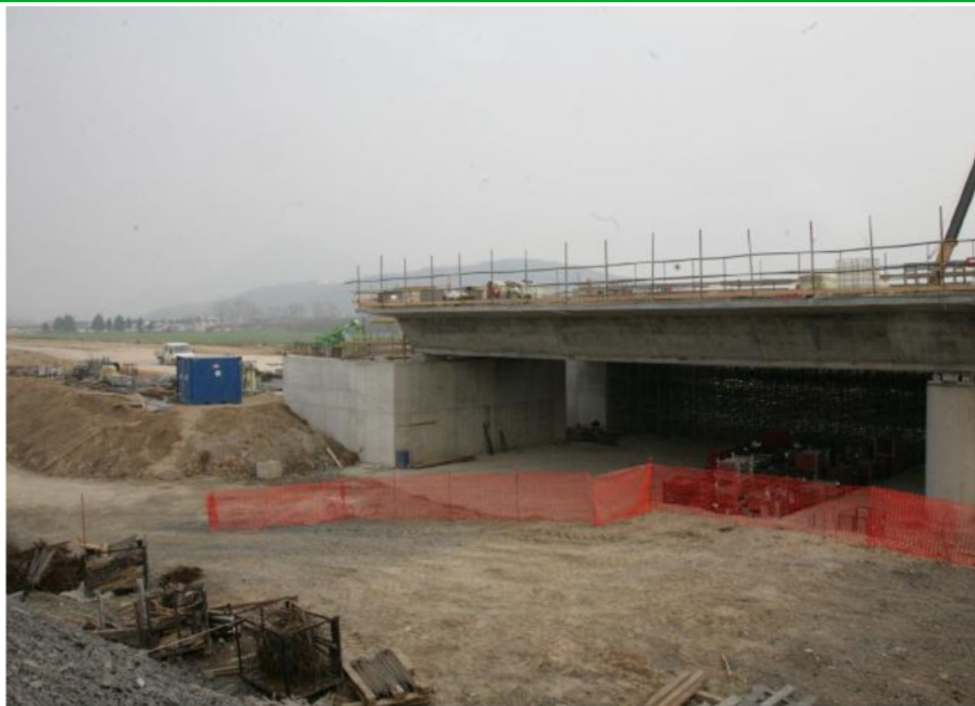
Durante i lavori per la realizzazione della Valdastico sud furono interrati anche dei rifiuti. ARCHIVIO
