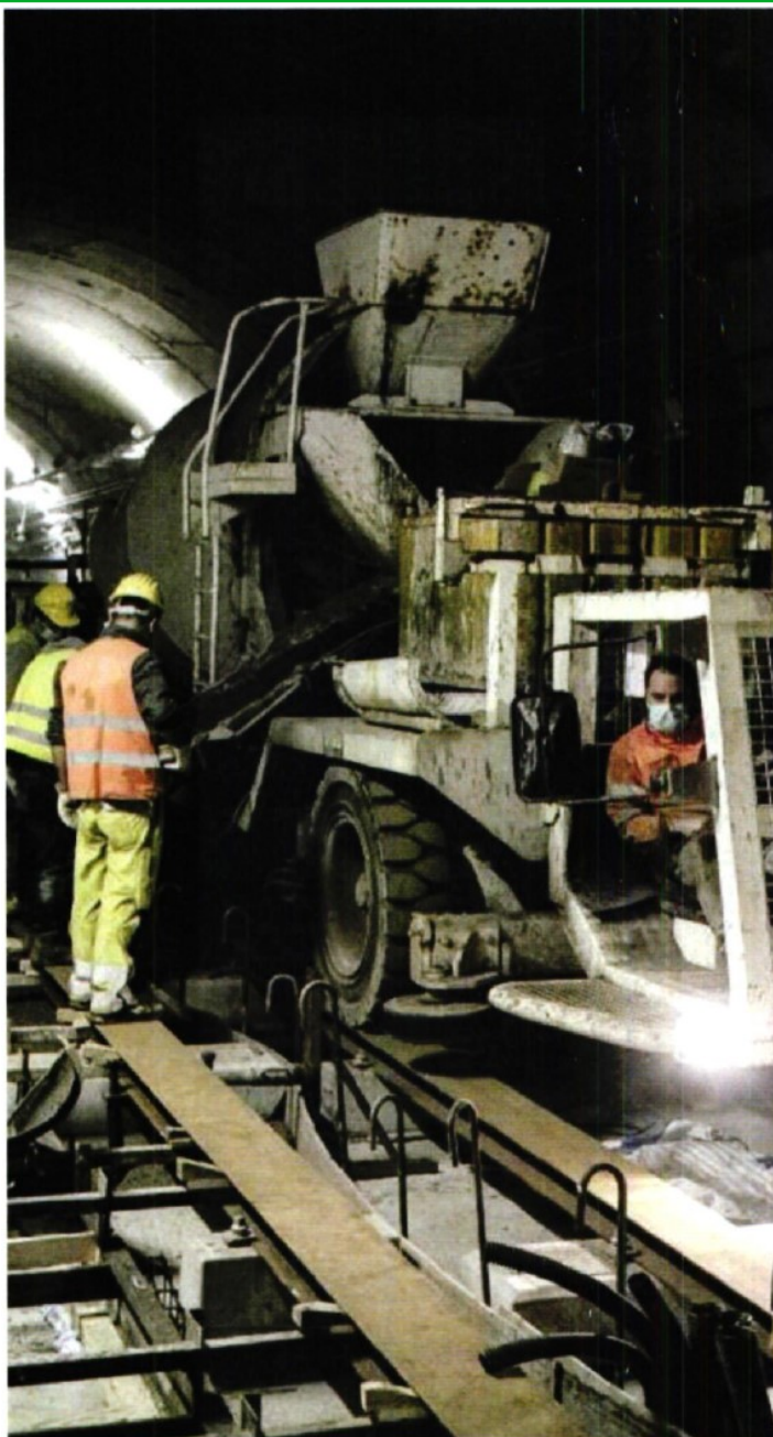
Operai con mascherina nel cantiere della Metro di Torino (Foto Lapresse)
