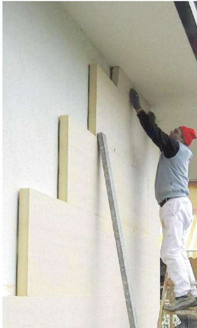
La posa del "cappotto" è uno degli interventi che beneficiano del bonus
