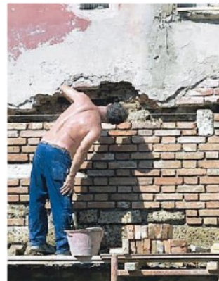
Lavori di restauro
