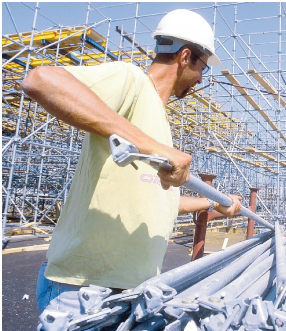
Un operaio al lavoro in un cantiere edile
