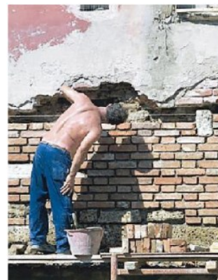
Lavori di restauro
