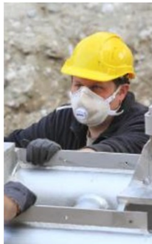
Operaio al lavoro in un cantiere
