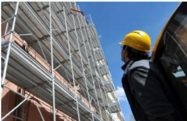
Un operaio durante l'installazione di un ponteggio in un cantiere
