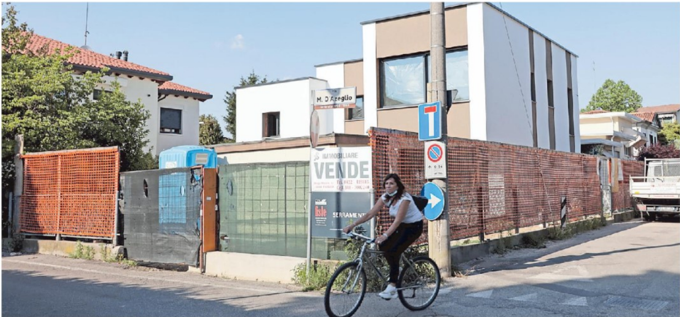
Una ristrutturazione in corso nel Comune di Treviso: sono oltre 266 mila gli edifici della nostra provincia che potranno beneficiare dell'ecobonus per la ristrutturazione
