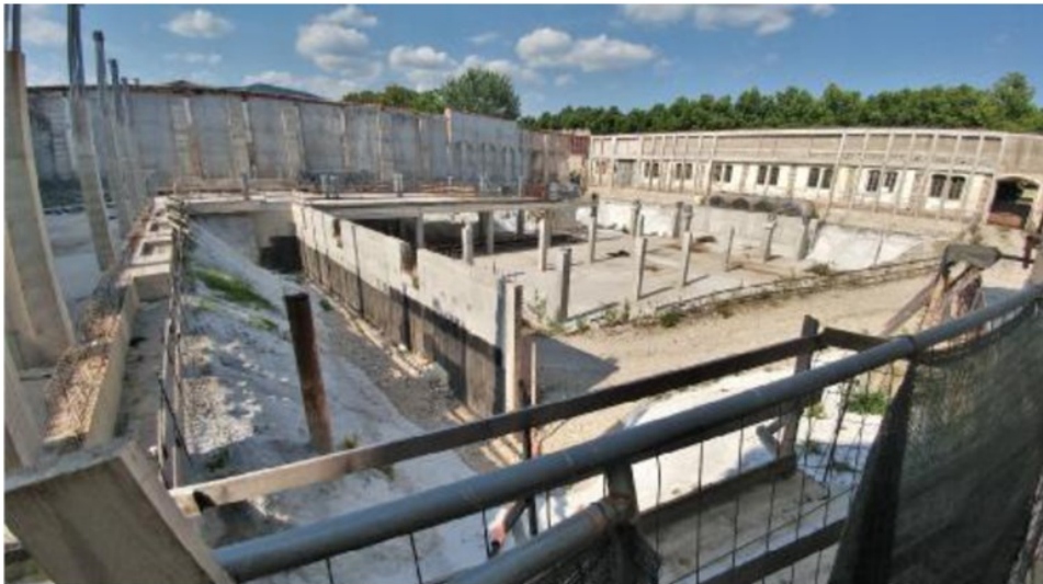
Così si presenta oggi il cantiere del Polo Santa Chiara, fermo da due anni FOTO CECCON
