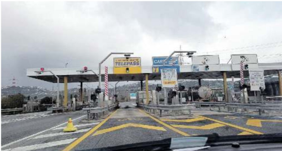
Un casello autostradale
