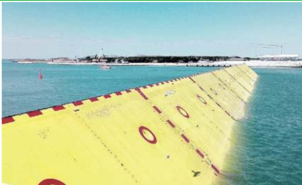
GRANDI OPERE Le barriere mobili del Mo.S.E, Modulo sperimentale elettromeccanico
