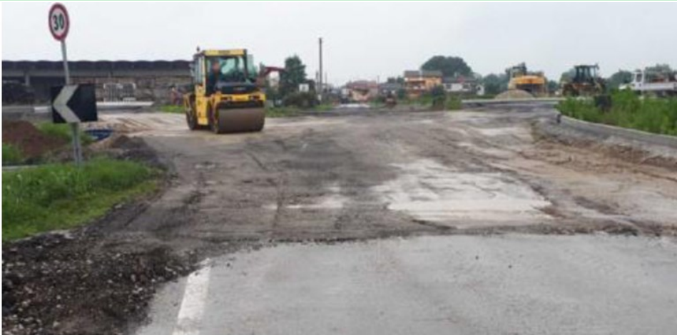
L'avvio del cantiere della futura rotonda del casello Mussolente-Loria
