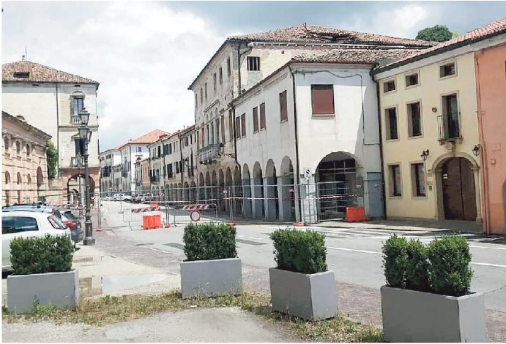
Palazzo Dante transennato: una parte della copertura è crollata
