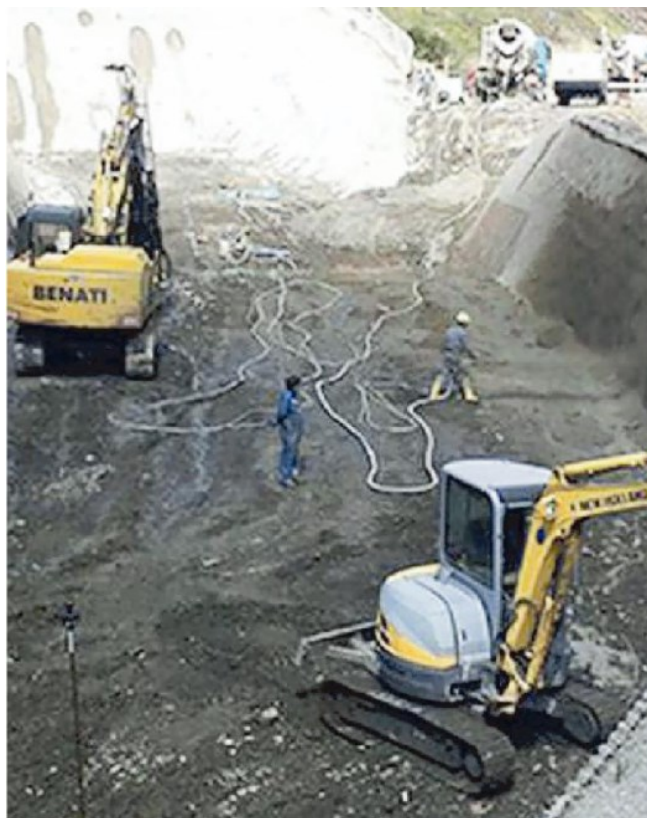
Uno dei cantieri di Emaprice sul Brennero
