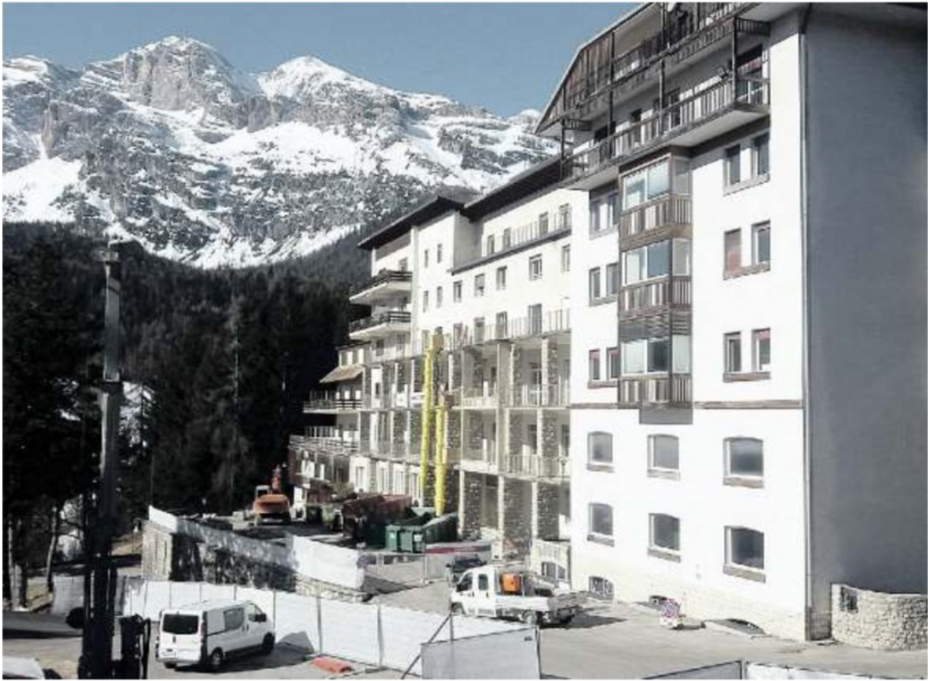
IL MAXI-CANTIERE La ristrutturazione del Codivilla, vinta dalla Emaprice, che vale la bella cifra di 18 milioni di euro
