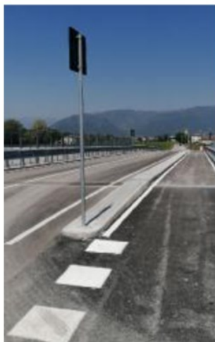
Il cavalcavia di via Andolfatto
