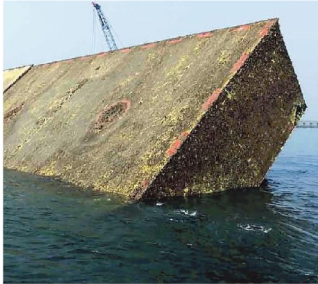
Mose, una paratoia mangiata dalla ruggine
