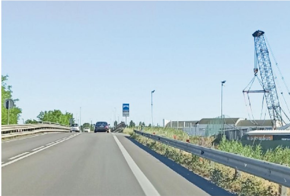
Il ponte sulla Fossetta in prossimità del Clodì, un asse stradale che ha bisogno di manutenzione
