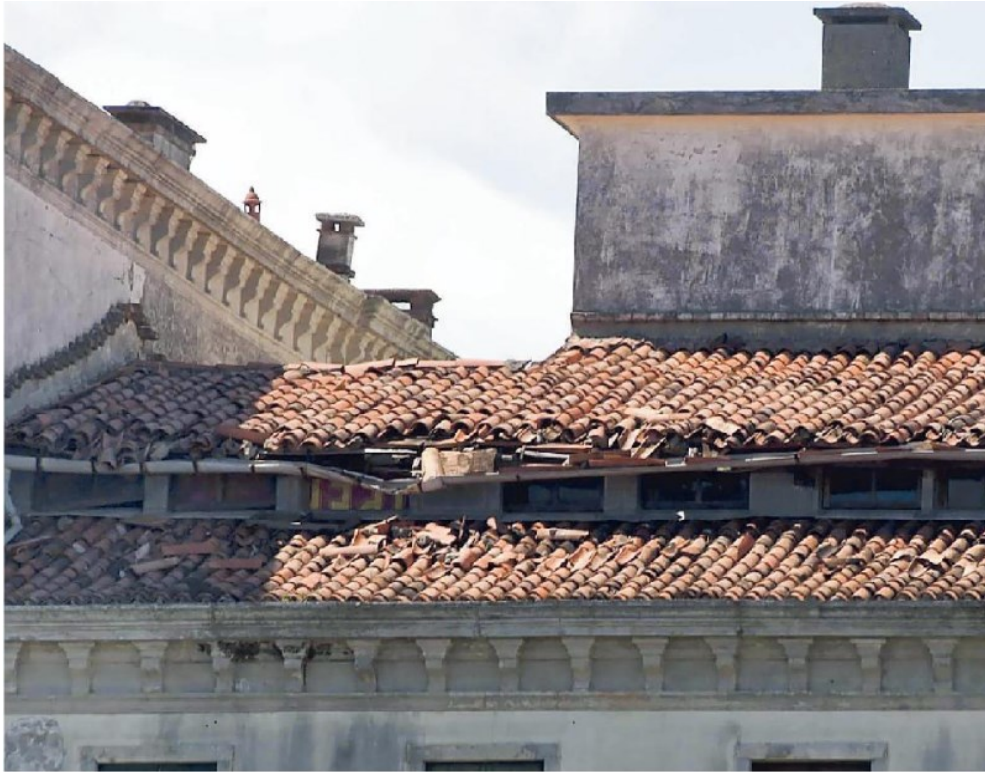
Le tegole che si sono staccate dal tetto dell'albergo Des Bains al Lido
