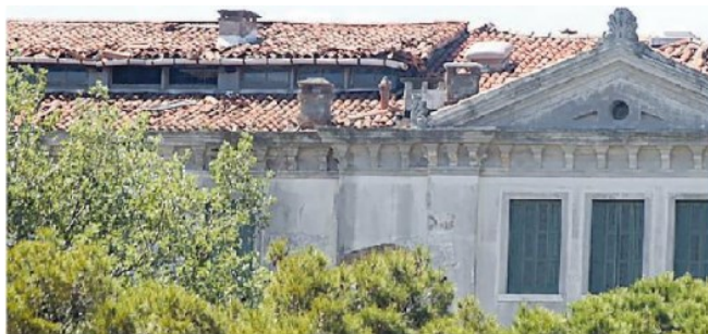
La zona dell'albergo in cui il tetto è più malandato
