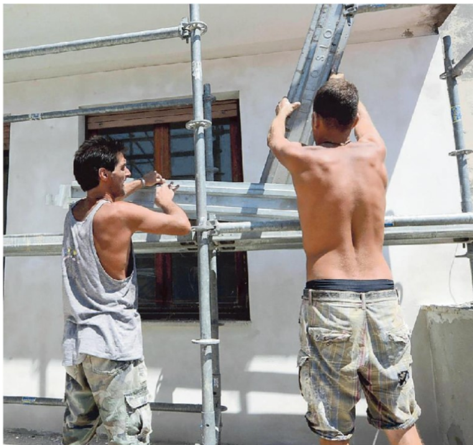
Lavoratori in azione in un cantiere edile
