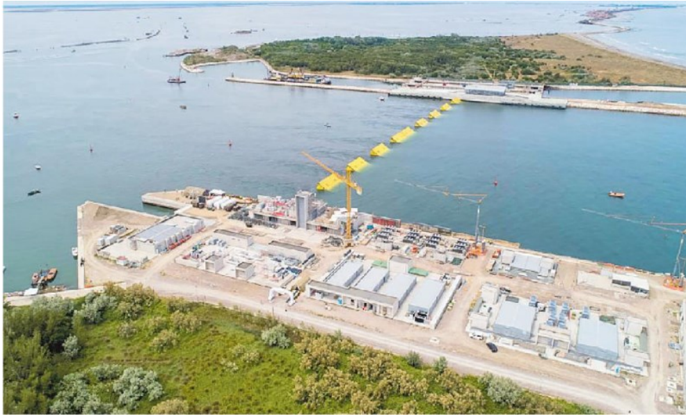
Le paratoie del Mose alla bocca di porto di Malamocco
