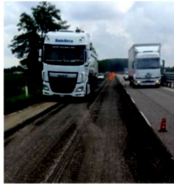
Lavori stradali sulla Transpolesana
