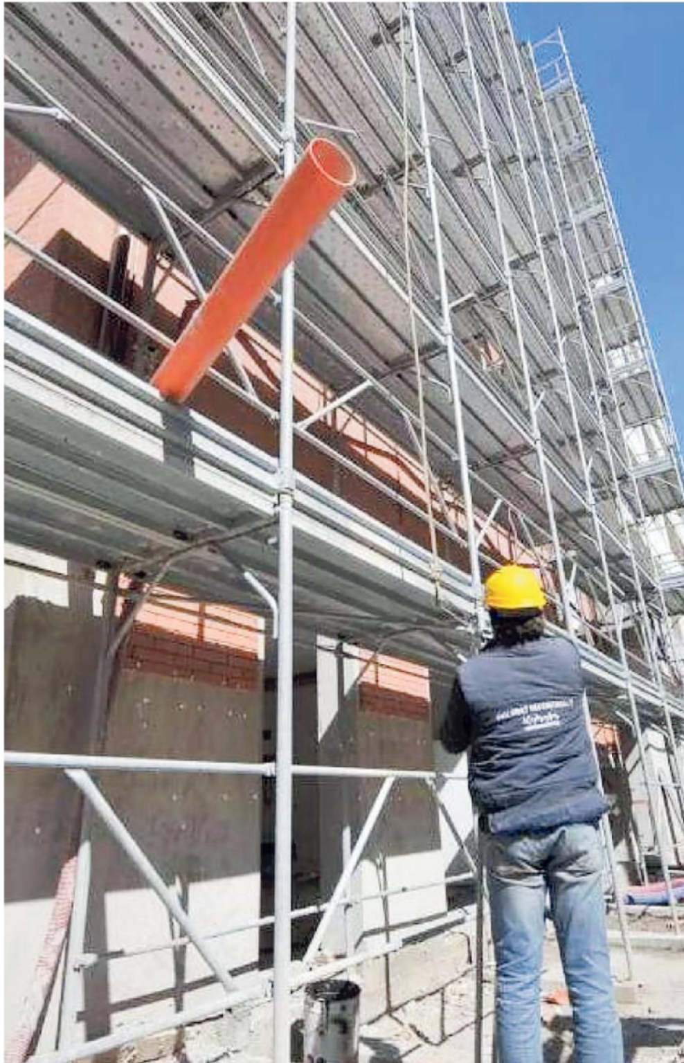
Un cantiere edile nel Veneziano: è partita la corsa alla ristrutturazione, grazie al Superbonus 110%
