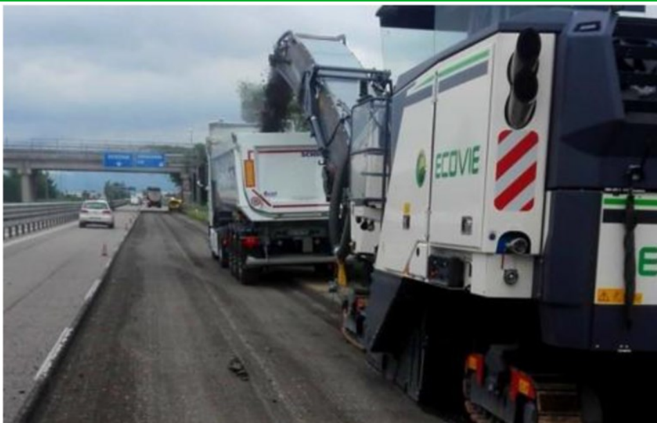
Mezzi al lavoro per asfaltare la Transpolesana
