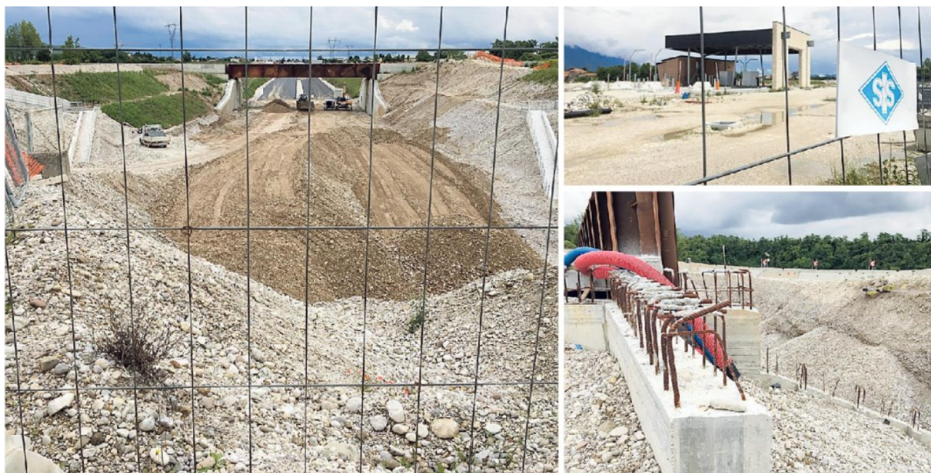
Qui sopra le lavorazioni della Pedemontana al confine tra il tratto Trevigiano e Vicentino, nella zona di Riese Pio X. In alto a destra il casello in costruzione nel tratto Breganze-Bassano del Grappa e sotto un particolare di uno dei viadotti che garantiranno la futura viabilità comunale nella zona di Povegliano
