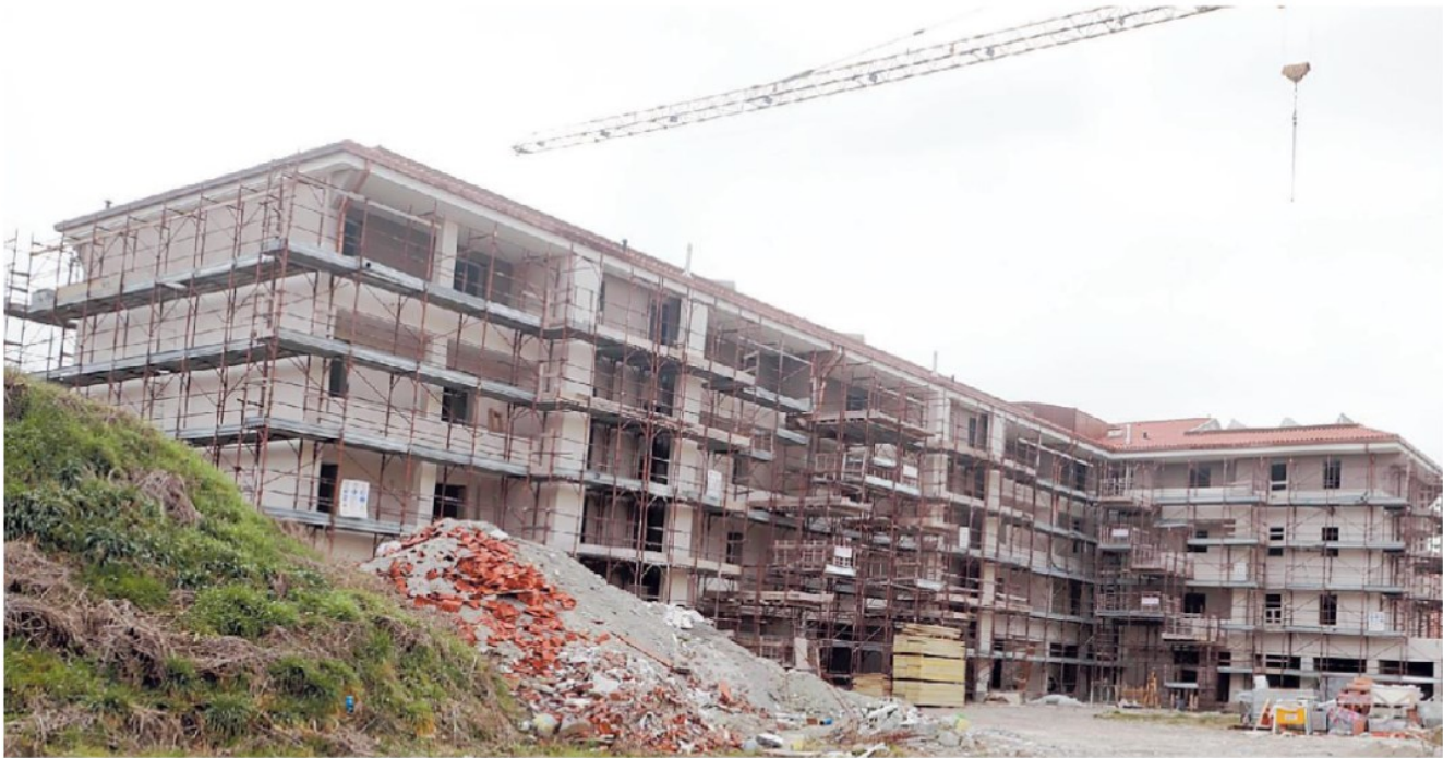
Il cantiere dell'Ater in strada La Bassa a Monigo prima del lockdown: ora servirà un nuovo bando per completare i lavori
