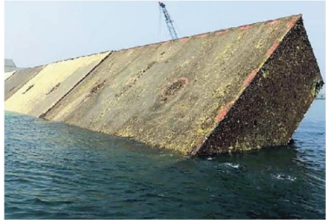
Le barriere arrugginite alla bocca di porto del Lido
