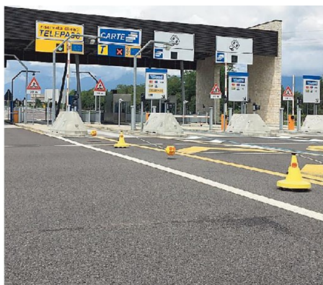
Il casello di ingresso in Pedemontana dall'A31 Valdastico
