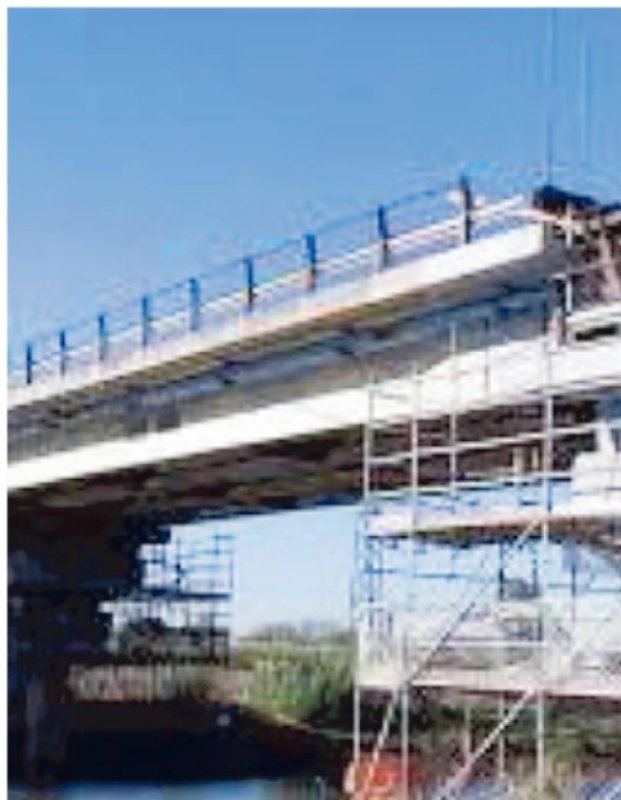
Un cantiere sulla Statale 14 Triestina
