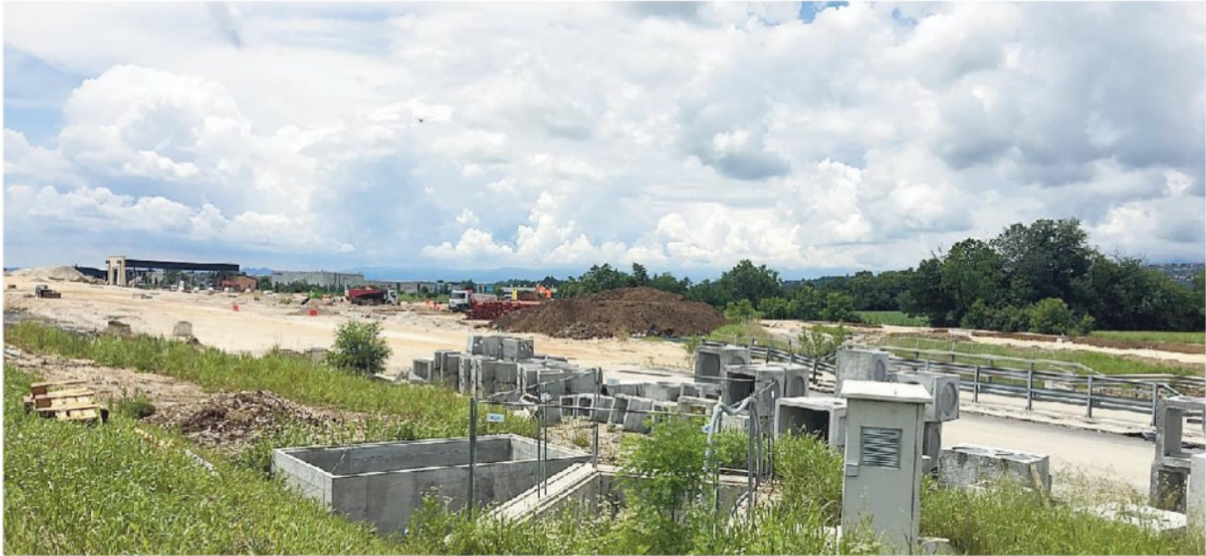
Il cantiere della Superstrada Pedemontana Veneta all'altezza del confine tra Trevigiano e Vicentino
