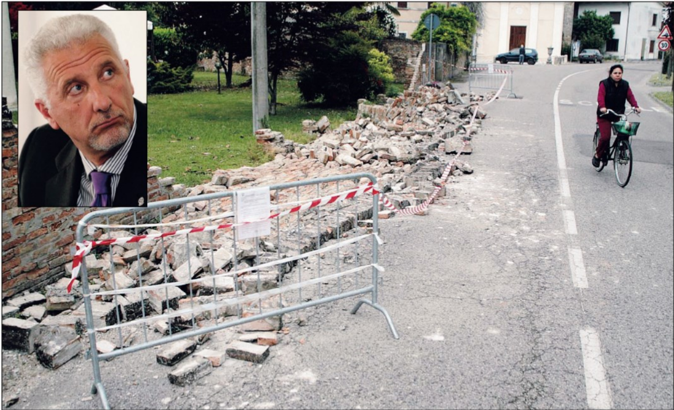
Alcuni danni fatti dal terremoto del 2012 in Polesine. Nel riquadro, il presidente di Ance Veneto Paolo Ghiotti
