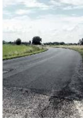
ASFALTO Steso il nuovo manto sulla provinciale
