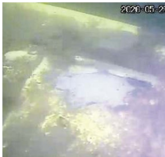
TREPORTI Il punto in cui la vernice risulta danneggiata sulla paratoia numero 9
