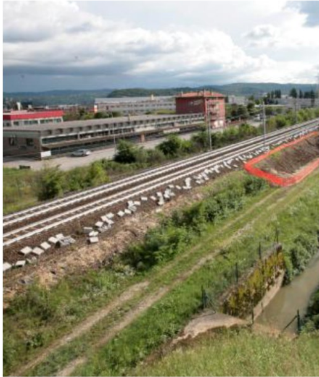
La strada di cantiere sarà creata sull'ex sedime Ftv lungo i binari
