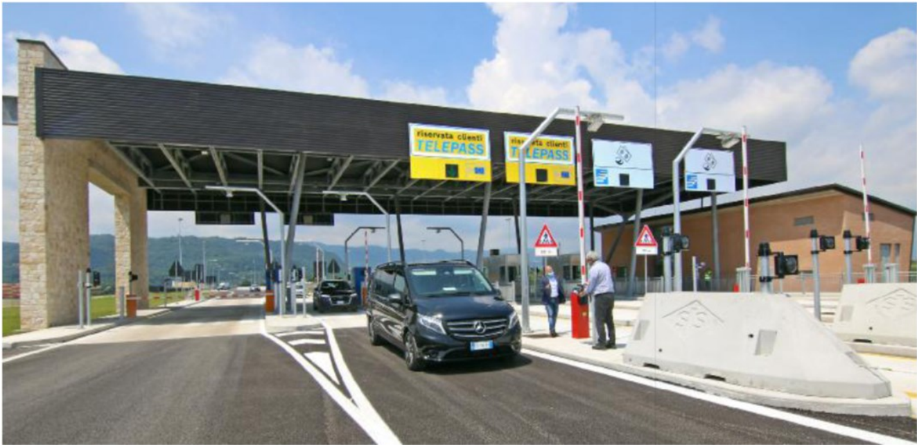
Il casello di Malo della Superstrada Pedemontana Veneta: da ieri è aperto. FOTOSERVIZIO DONOVAN CISCATO
