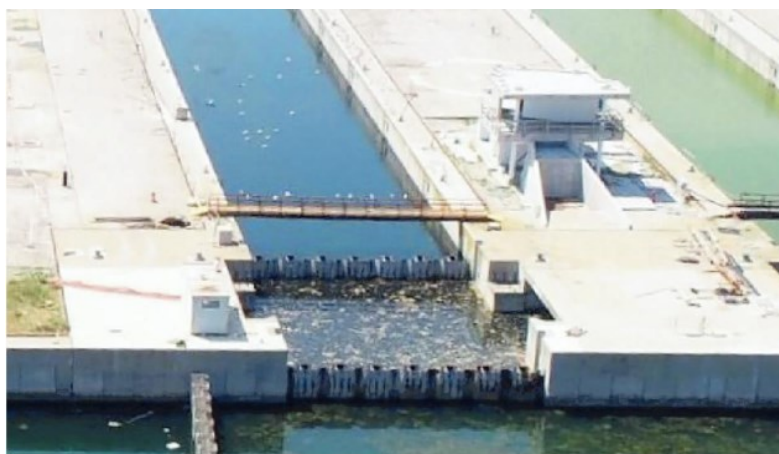
L'altra conca incompiuta, a Chioggia: palancole di ferro al posto delle porte
