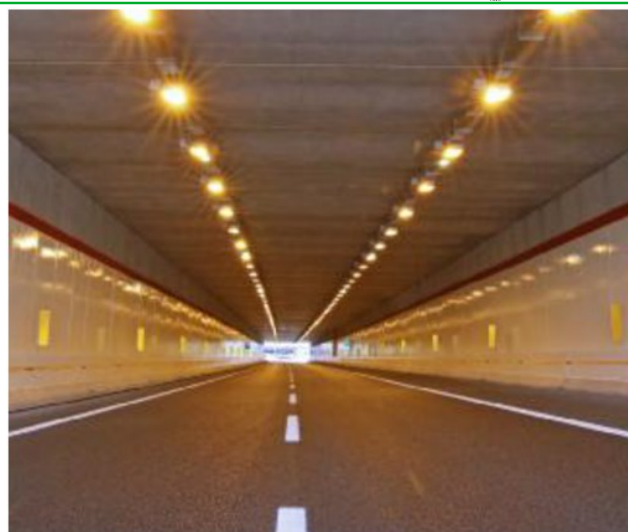
Una delle gallerie artificiali del nuovo tratto di Pedemontana
