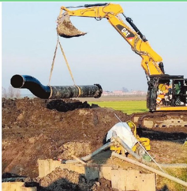
Un cantiere di Acquevenete per il servizio idrico
