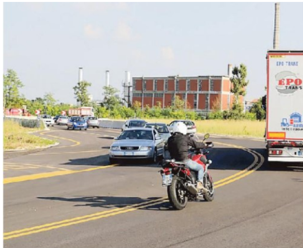
Il cantiere della Pedemontana all'altezza della Pontebbana
