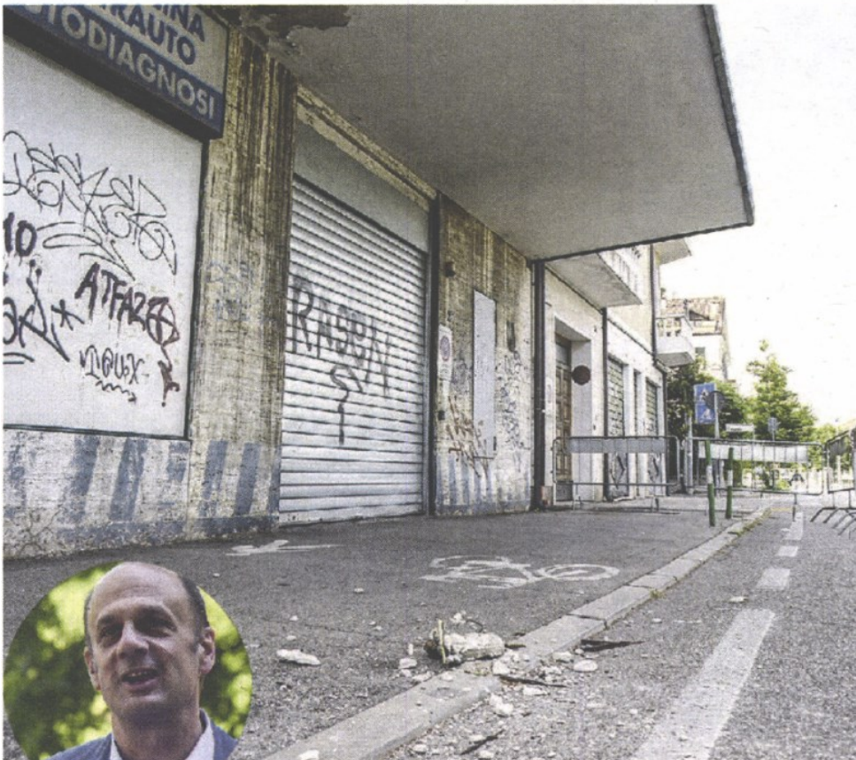
RISCHIOSO La pensilina del condominio perde calcinacci. La zona è stata messa in sicurezza. Nel fondo, il vicesindaco Arturo Lorenzoni
