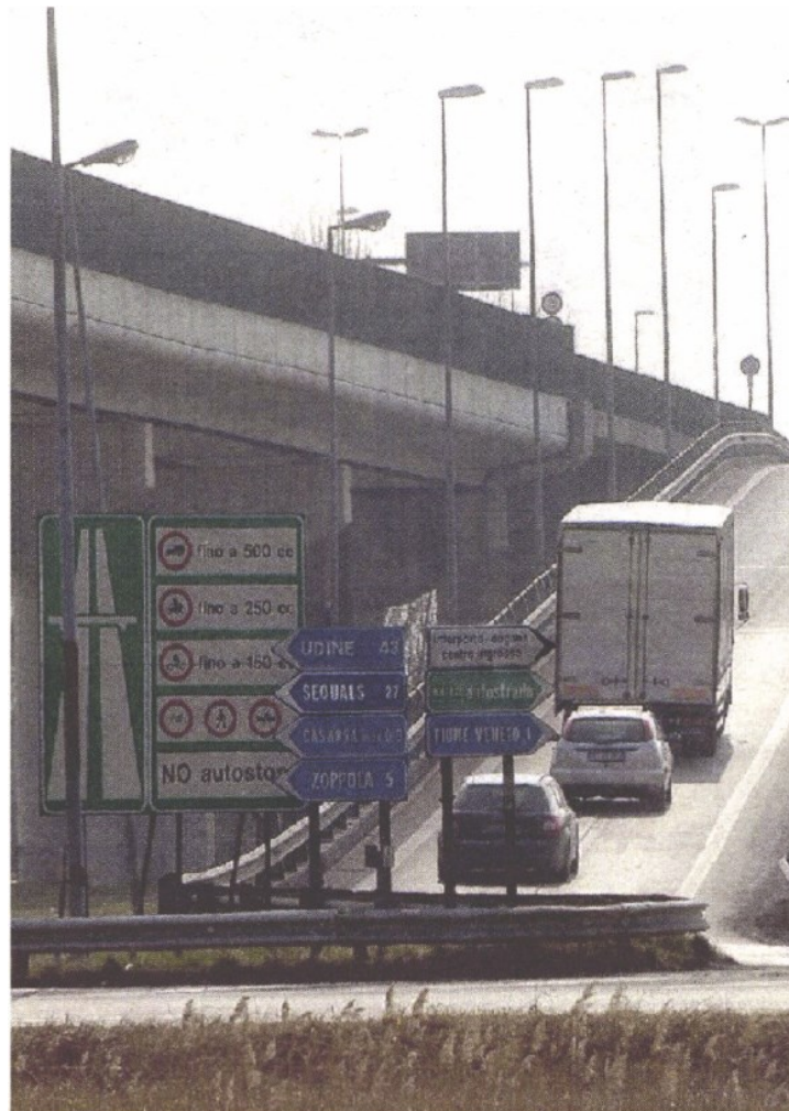
VIABILITÀ Il viadotto "Moro" nei pressi di Pian di Pan
