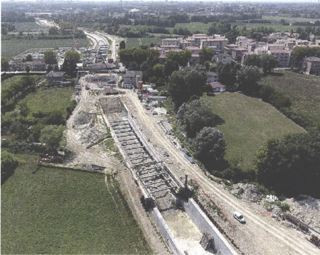
IN DIRITTURA Un'immagine aerea di alcuni mesi fa del by-pass di Campalto, ora quasi completato
