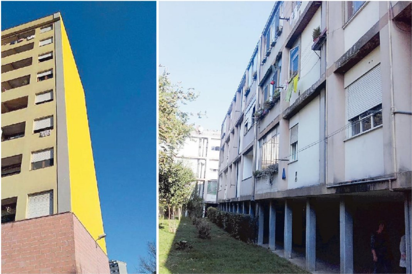
Gli interventi di riqualificazione energetica saranno realizzati nei palazzi Ater di Favaro, in via Triestina e in via Monte Prabello
