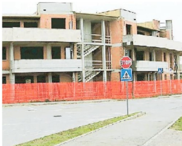
Un condominio in ristrutturazione
