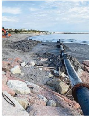
Lavori per i ripascimenti
