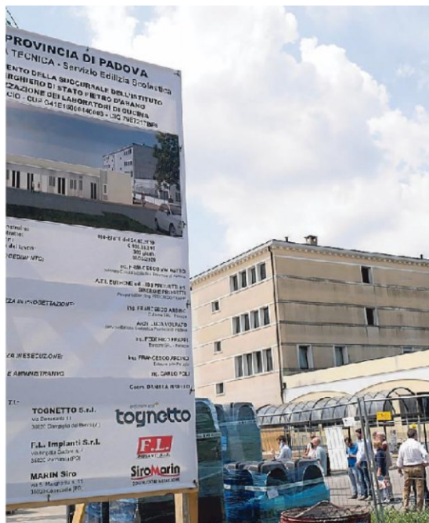
Il cantiere per l'ampliamento dell'Alberghiero di Abano Terme
