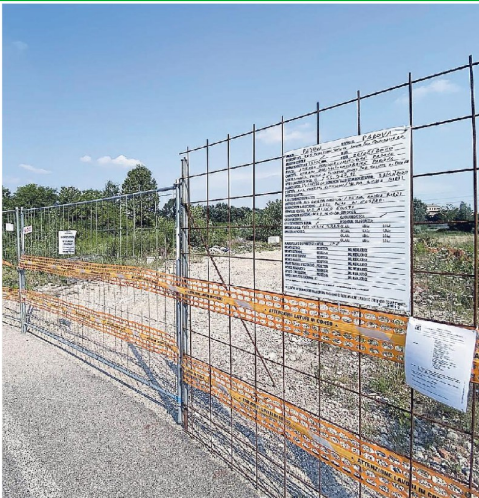
Il cantiere del nuovo ospedale a San Lazzaro: al via le indagini preliminari
