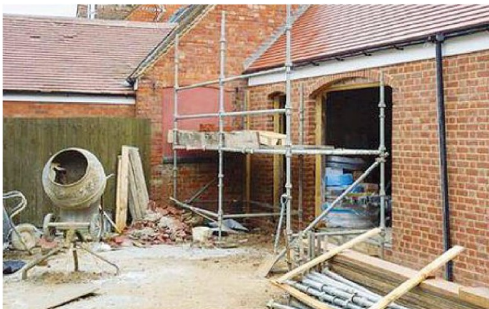
Cappotto Fra gli interventi su cui punta l'ecobonus c'è il rifacimento del cappotto per l'isolamento termico delle abitazioni
