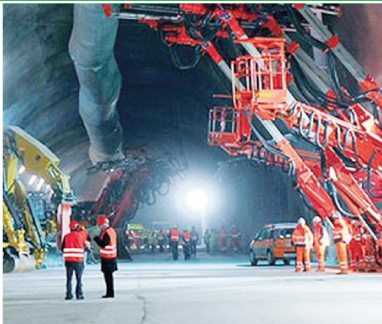
Condotte. I lavori presso la galleria di base del Ceneri, in Svizzera
