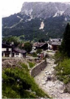
I PRIMI lavori di contenimento del Bigontina iniziati nel 2019
