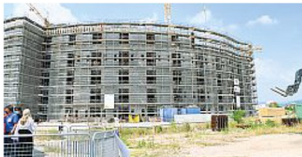
Cantiere ripartito L'ospedale di Montecchio sarà pronto a fine 2021
