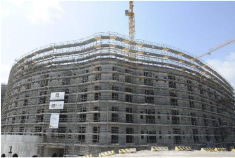
La struttura del nuovo ospedale di Montecchio-Arzignano è arrivata al quinto piano. FOTO TROGU
