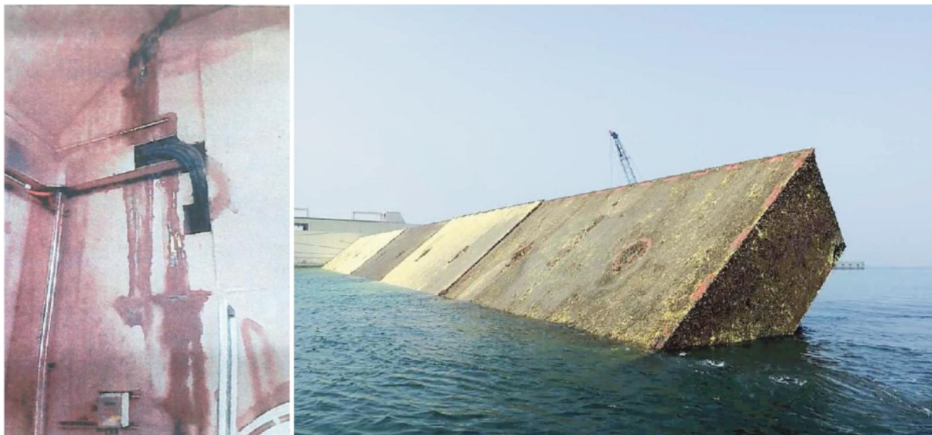
Una foto che evidenzia la presenza di infiltrazioni di acqua e umidità nelle gallerie e una delle paratoie con problemi di corrosione alla barriera di Treporti
