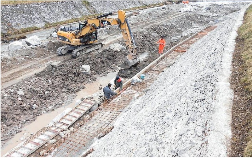
Lavori di sistemazione idraulica in un cantiere: per le imprese venete è difficile ottenerli
