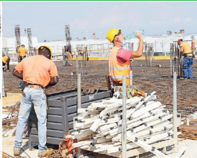
Lavori sul piano F, l'ultimo dei sei livelli
