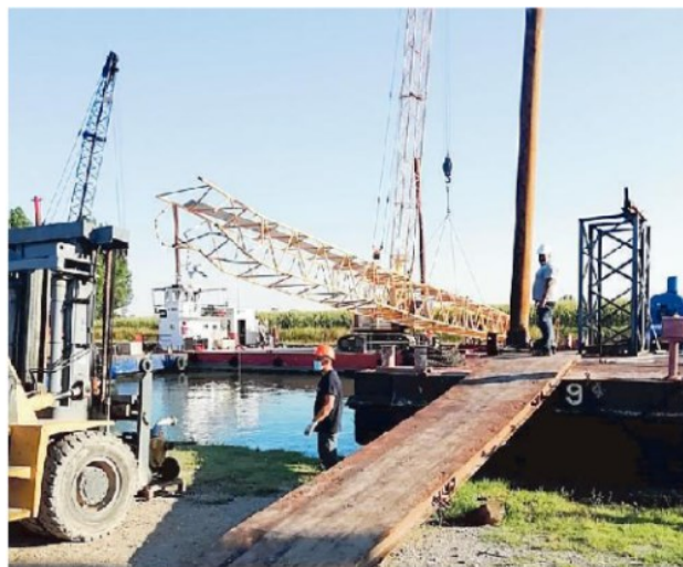
Le operazioni di recupero della grande gru
