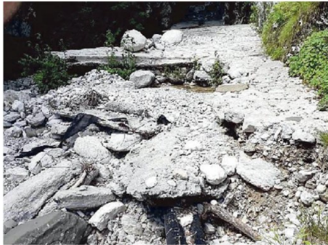
Le condizioni della strada della Val Medon, distrutta da Vaia
