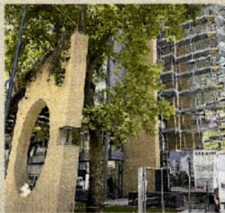
Trevisan a pagina XII EDILIZIA Il cantiere in via Pio X
