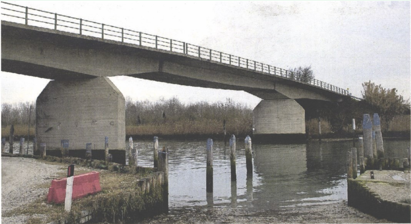
SUL CANALE CAVANELLA Il ponte di Valvecchia, lungo la strada provinciale 70 Portogruaro-Brussa, risale al 1968
