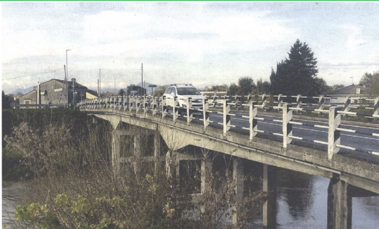
PONTE Partono i lavori per la demolizione della vecchia struttura e la costruzione di quella nuova. Sopra il sindaco Matteo Cecchinato
