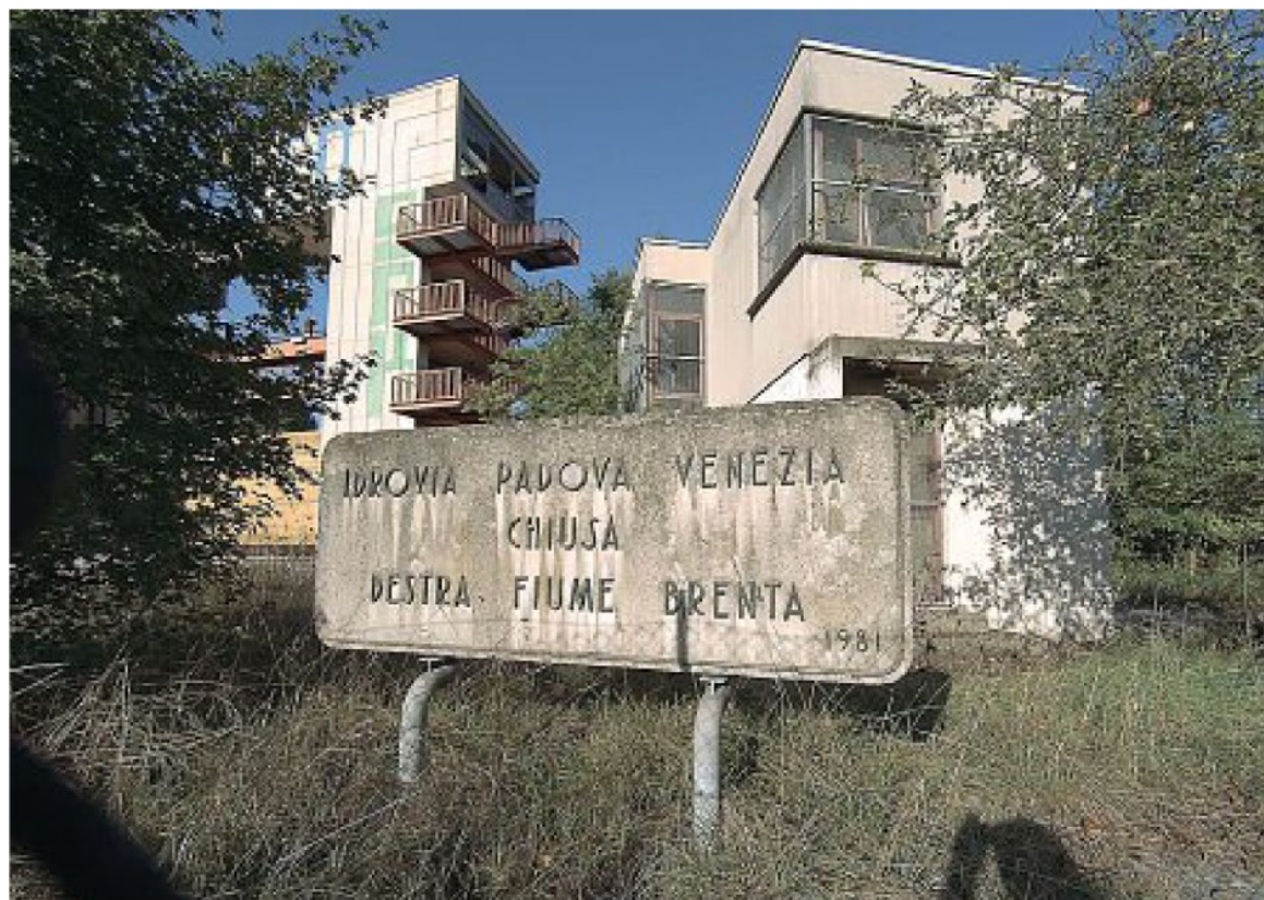
In stato di abbandono I cantieri dell'idrovia sono fermi dal 1985. L'opera, ideata nel 1955, dovrebbe collegare Padova a Venezia
