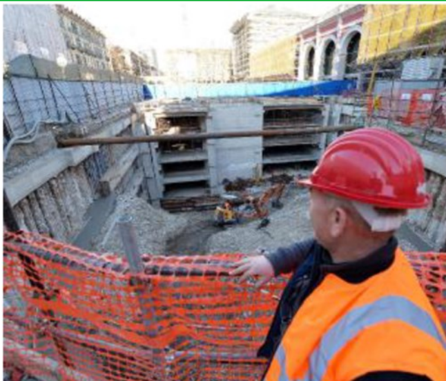
Il cantiere di un'opera pubblica
