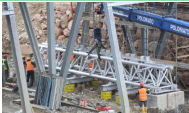
Il posizionamento sotto la seconda stilata è riuscito al primo tentativo
