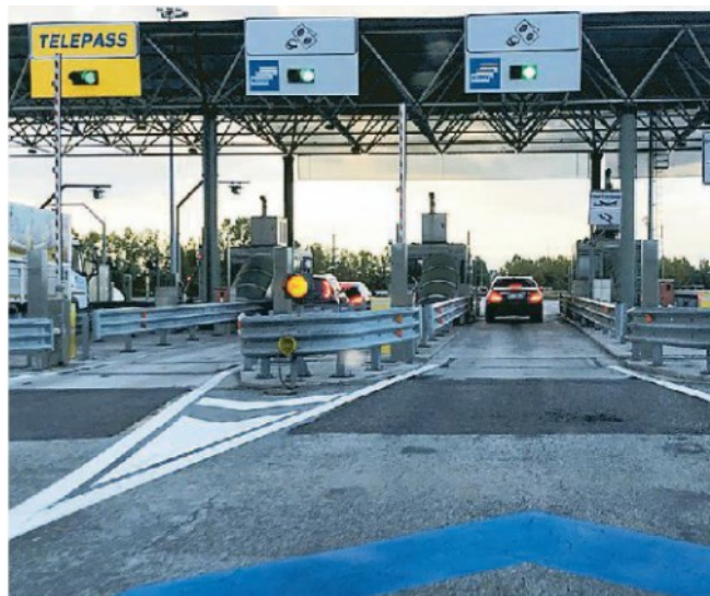
Il casello autostradale
