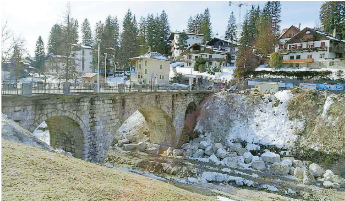
Lavori in corso sotto il ponte Corona, per la sistemazione delle sponde del Boite
