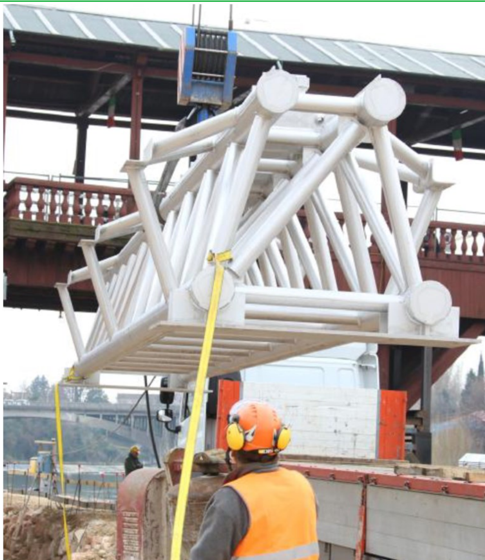
Le operazioni di installazione della prima delle maxi-travi in acciaio destinta a sorreggere le stilate
