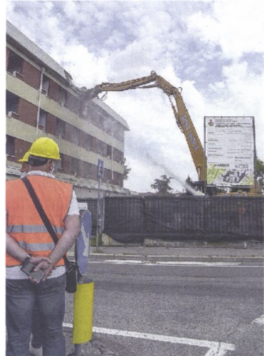
IL COMPLESSO Sabato comincia l'ultimo abbattimento
