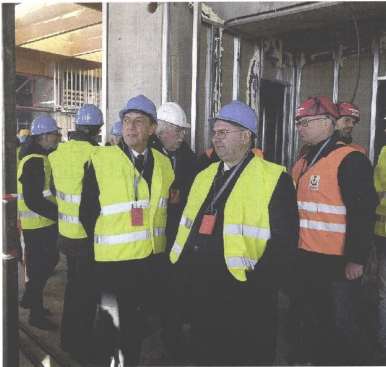
GIORDANI Il sindaco con il presidente Bui in uno dei sopralluoghi al cantiere del palacongressi
