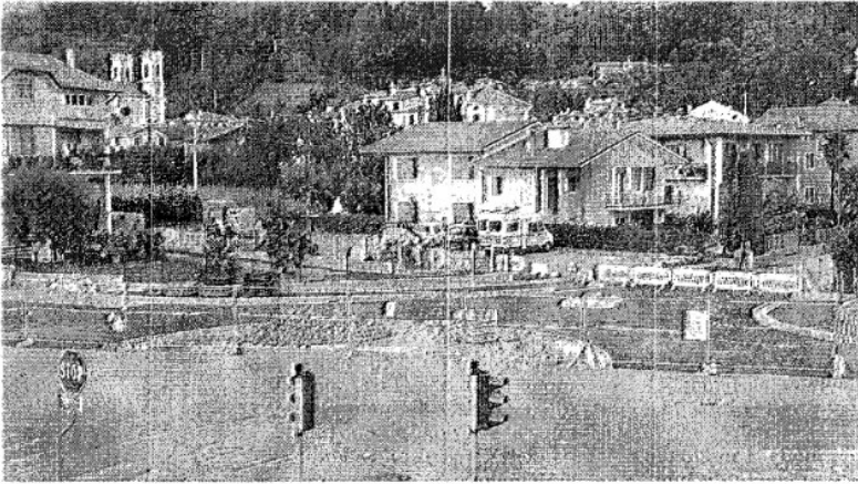
Il cantiere per la realizzazione della nuova rotatoria fra via Tedesca e via Marconi a Carrè. S.D.M.
