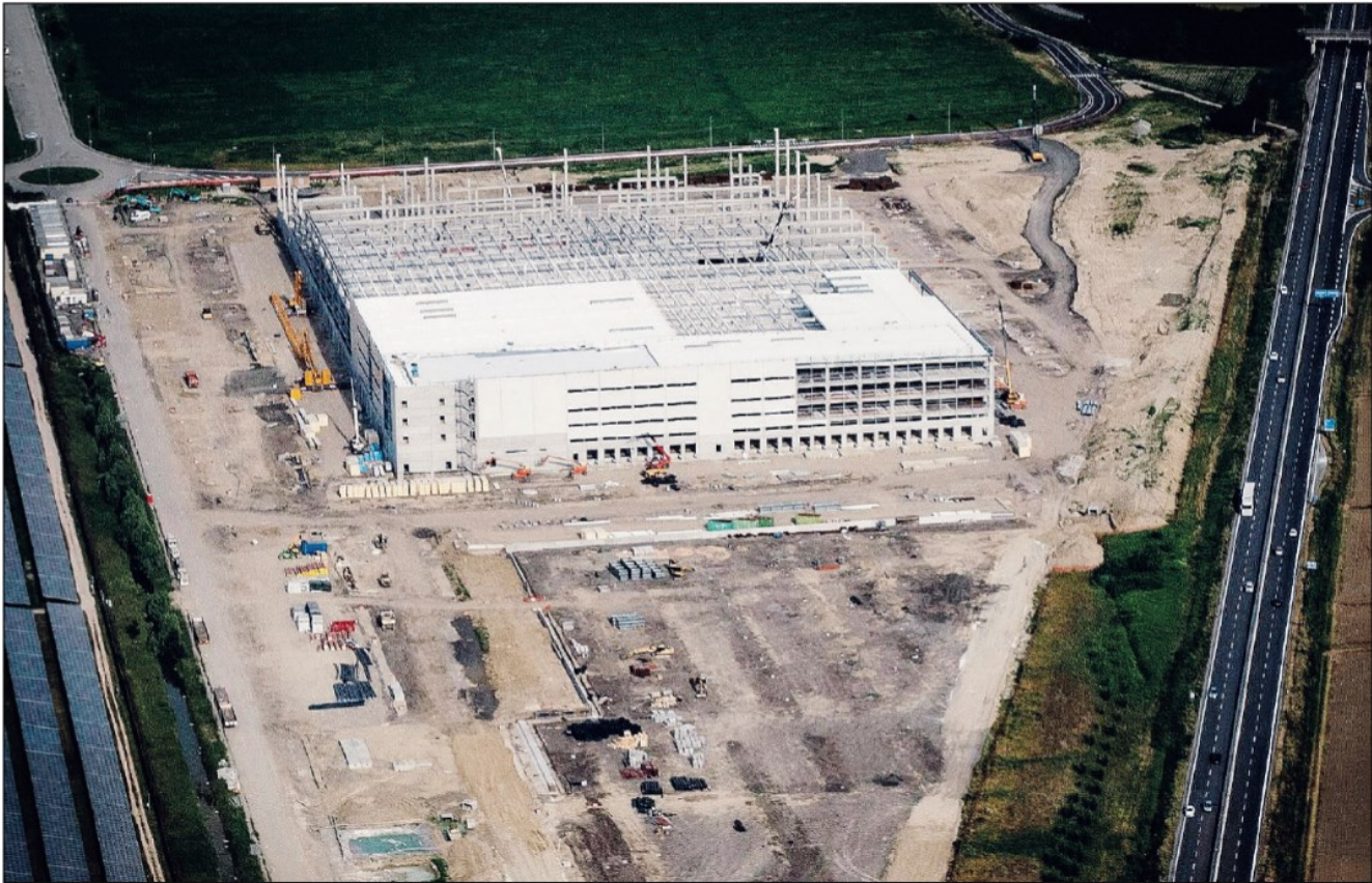
Una foto aerea del grande complesso di Amazon, qui ancora in costruzione, a ridosso della Transpolesana
