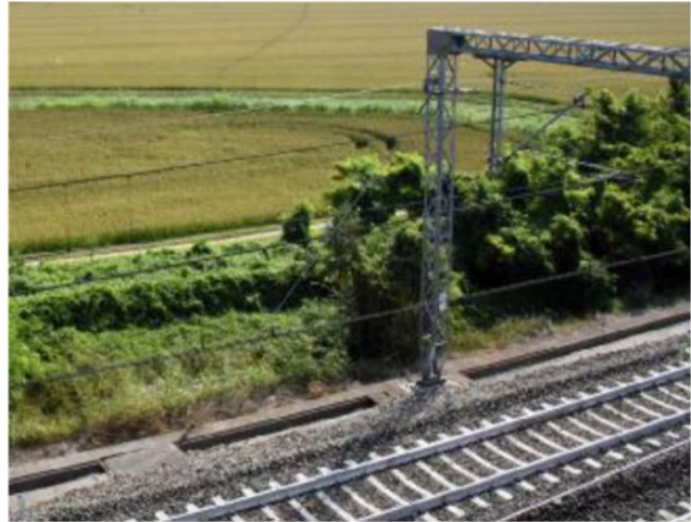
La ferrovia di Isola della Scala dove sarà costruito il terminal DIENNE
