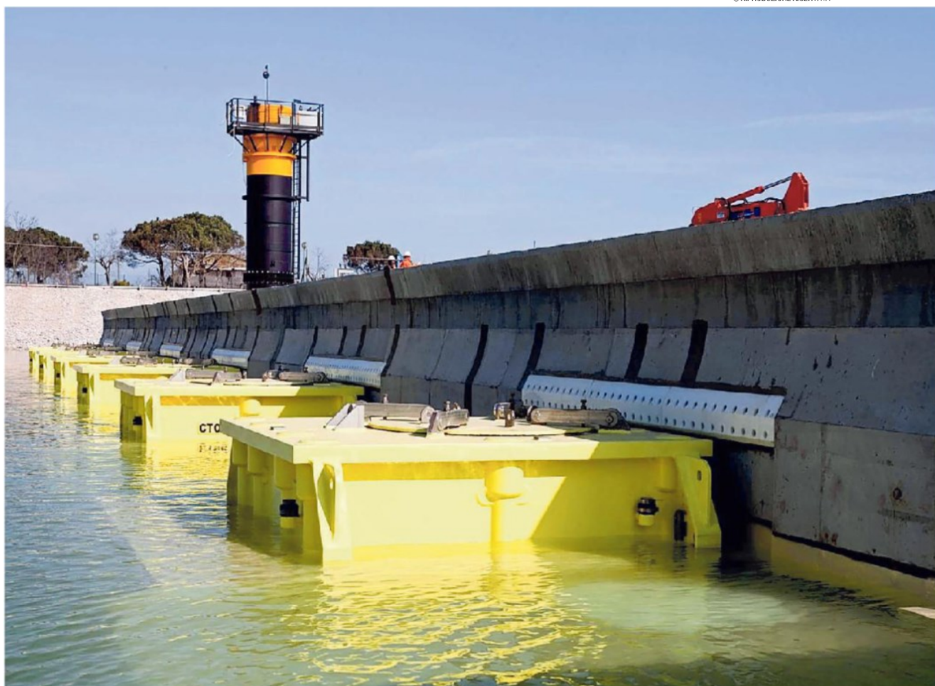
Un'immagine delle cerniere del Mose: continuano i problemi di ossidazione e presenza di acqua nei cassoni
