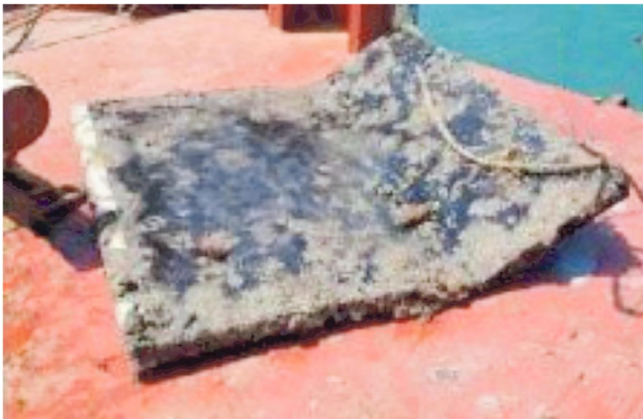
Una delle alette danneggiate del Mose: la lista dei guai della grande opera è lunga
