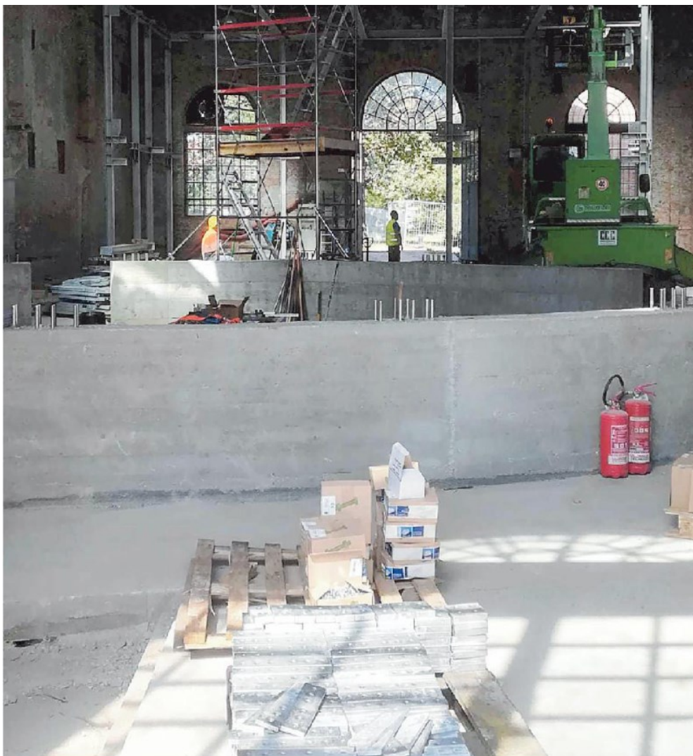
L'interno della Tesa 112 nell'Arsenale Nord che dovrà diventare il "cuore" del Mose
