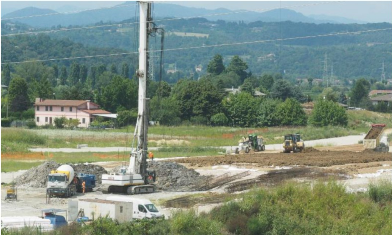
La bretella dell'Albera dovrà essere terminata entro il 31 maggio del 2021. FOTO ARCHIVIO
