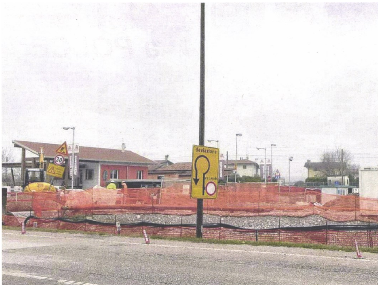
GRANDI OPERE Il cantiere della Bretella Sud in via Udine; il Comune vorrebbe prolungare l'arteria sino a Vallenoncello
