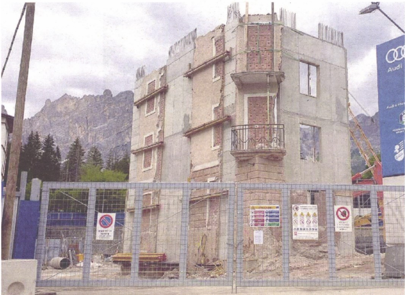
IL CANTIERE dell'hotel Ampezzo fermo dopo la decisione del tribunale di approfondire alcuni aspetti legati alla concessione
