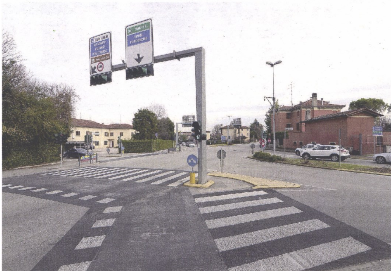
SAN LIBERALE L'incrocio di via San Liberale con la Pontebbana: assegnato il cantiere per la realizzazione della rotonda
