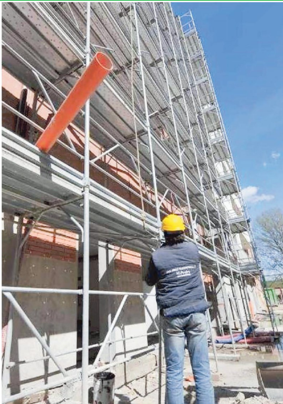
Un operaio al lavoro in un cantiere edile. Sabato in Fiera a Pordenone si parlerà di cantieri 4.0
