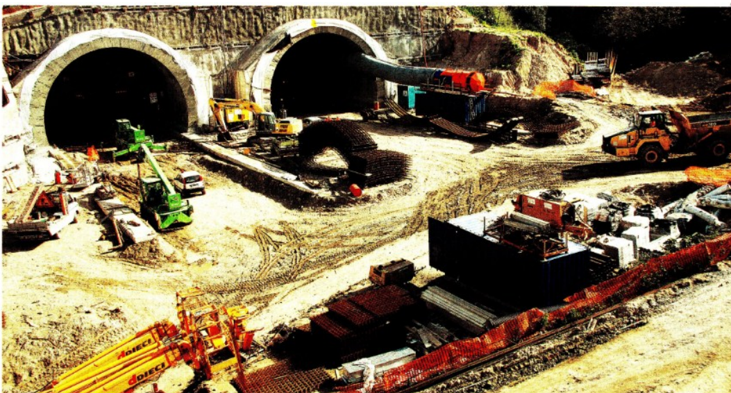
Fuori dal tunnel. Lavori di adeguamento e ammodernamento delle gallerie dell'Autostrada Salerno-Reggio Calabria, oggi A2. La Salerno-Reggio Calabria, oggi completata dopo molti anni di lavori sul percorso, è stata a lungo il simbolo dell'arretratezza del sistema autostradale italiano e della lentezza dei lavori di adeguamento
