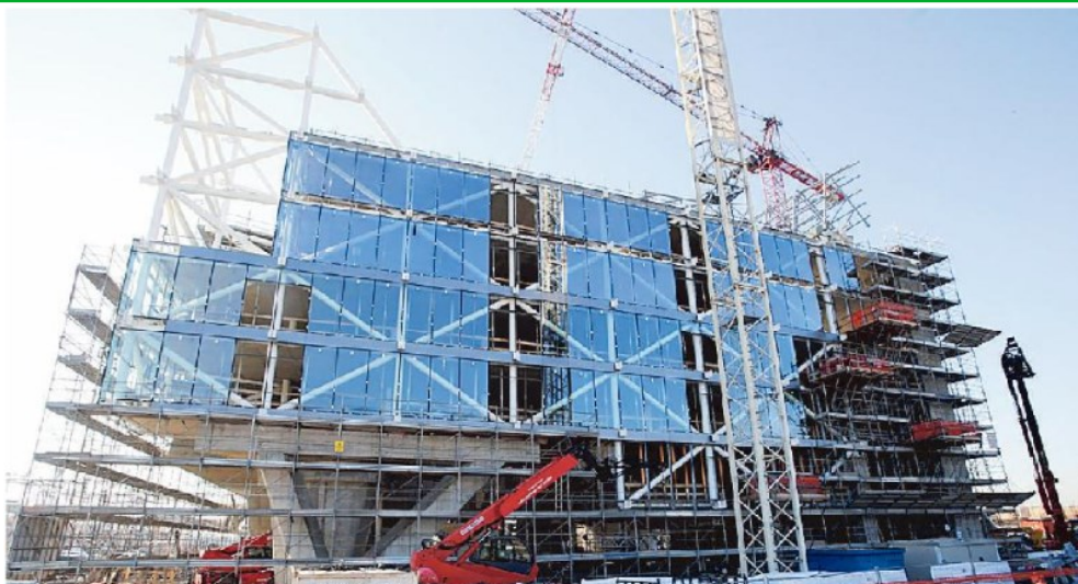
Un cantiere edile: i provvedimenti del governo mirano a rilanciare con forza il settore delle costruzioni
