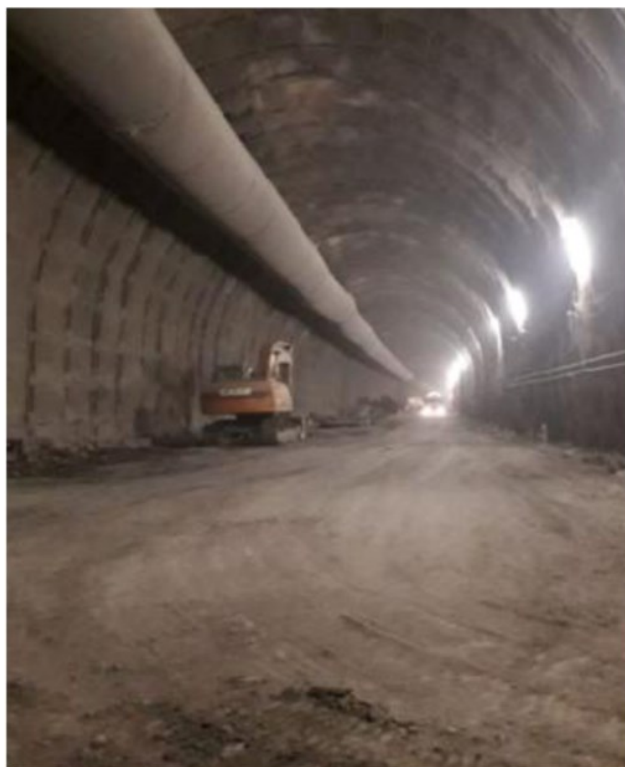
Il tunnel di servizio a Vallugana per bypassare i sequestri. MACA.
