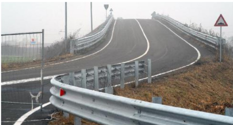
Il cavalcavia di Boschi Sant'Anna inaugurato nel 2008 e già minato da infiltrazioni
