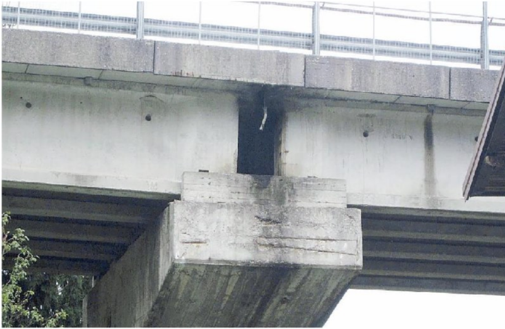
Alcuni particolari del viadotto deteriorato in più punti. L'Anas sta per avviare i lavori di ristrutturazione
