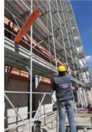
Un cantiere edile
