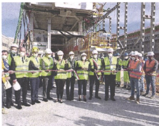
TAGLIO DEL NASTRO Il via ai lavori nel cantiere di Lonato
