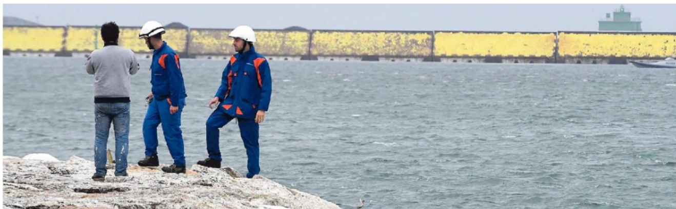
I tecnici del Consorzio Venezia Nuova osservano le paratoie tutte alzate. Sabato scorso con marea prevista oltre i 130 centimetri è stat messo in funzione il Mose
