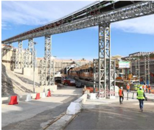
Uno scorcio del cantiere a Lonato (Bs) che punta all'area del Garda
