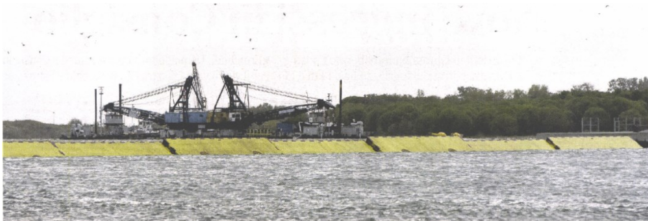
SOLLEVAMENTO La movimentazione di sabato scorso delle paratoie del Mose avvenuta in condizioni meteo avverse e che ha dimostrato l'efficacia del sistema
