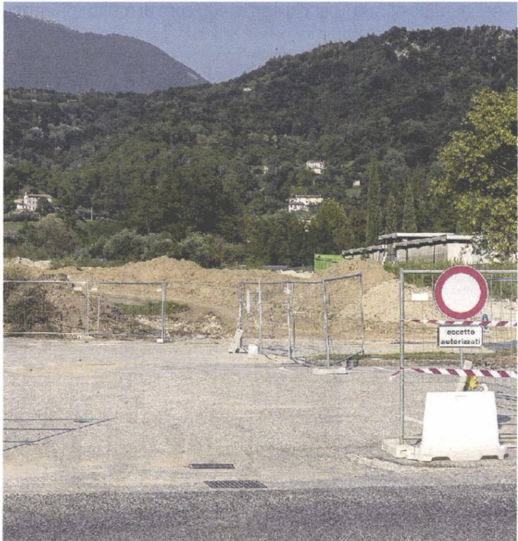
I LAVORI La sistemazione del parcheggio del cimitero di Sant'Andrea all'uscita di via Carso
