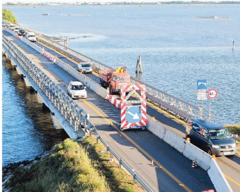
Un primo piano sulla segnaletica del cantiere al ponte translagunare
