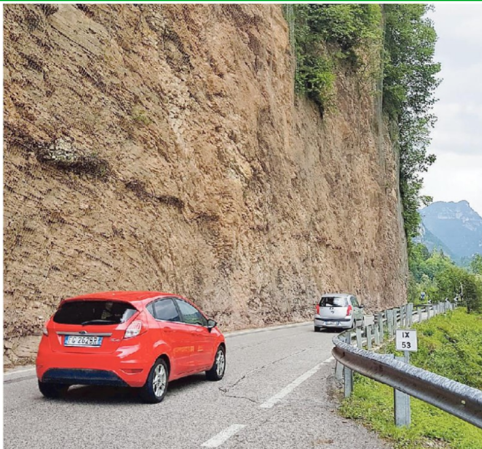
Il progetto per la galleria Pala Rossa 2 e per il ponte sul Cismon è alle fasi conclusive
