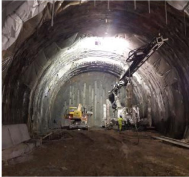
Lo scavo del tunnel della Pedemontana tra Malo e Castelgomberto
