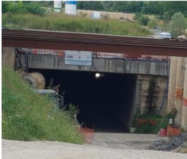
L'imbocco del tunnel sul lato della valle dell'Agno. ARCHIVIO
