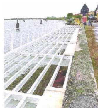
Il cantiere della pista ciclabile
