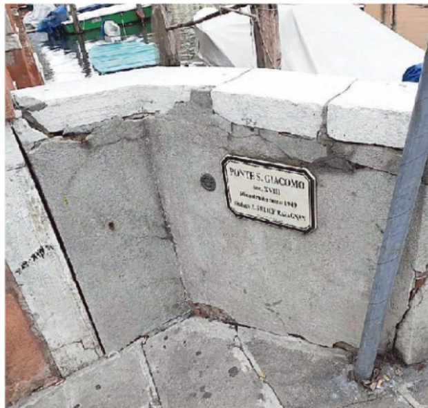
Lo stato di degrado e pericolosità in cui versa ponte San Giacomo
