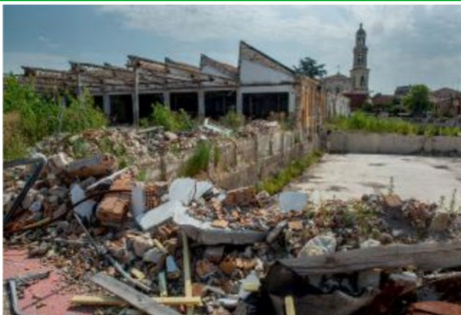
L'area dell'ex stabilimento Tiberghien in corso Venezia
