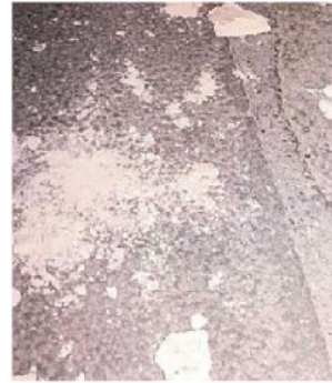
Detriti ai piedi del ponte Scarpa
