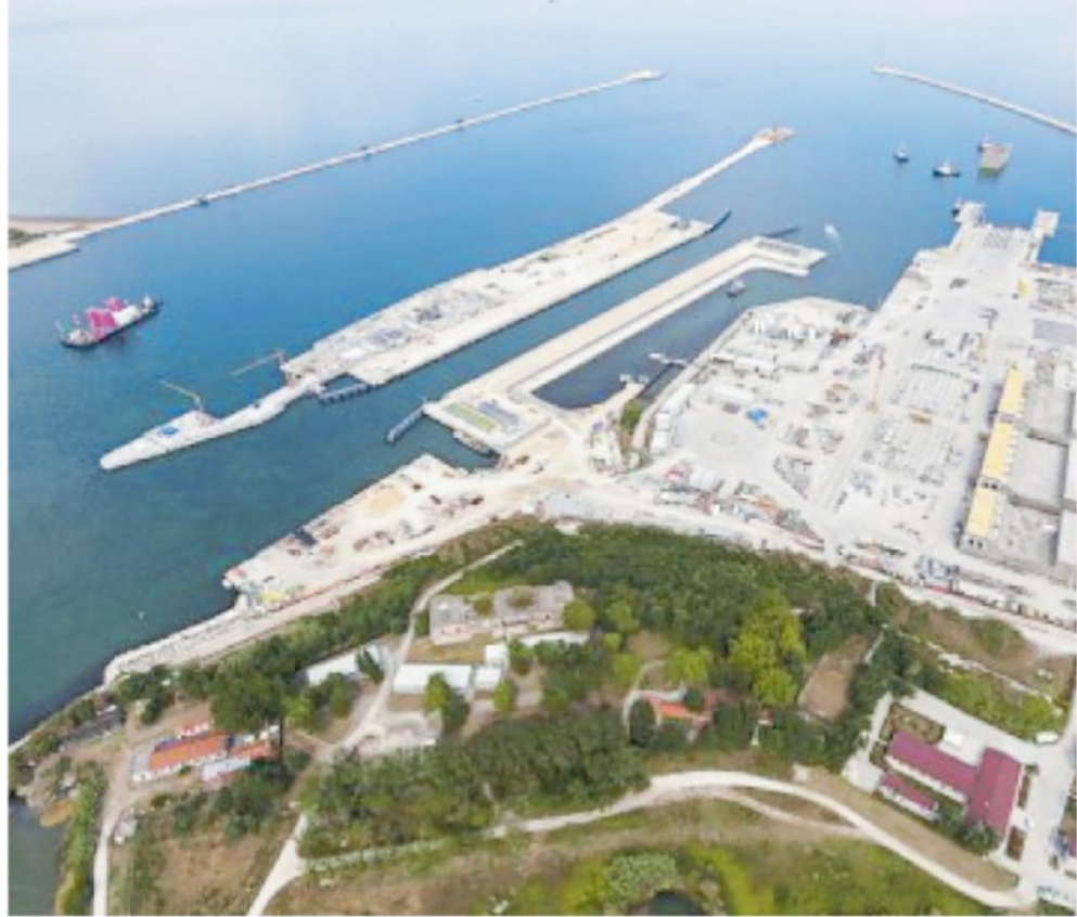
La conca di navigazione di Malamocco, costruita nell'ambito del sistema Mose
