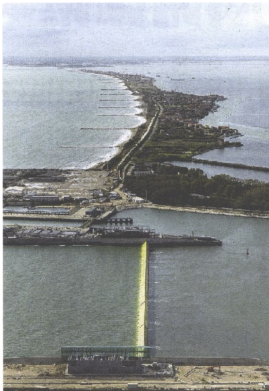
IN FUNZIONE Il Mose sollevato a Malamocco
