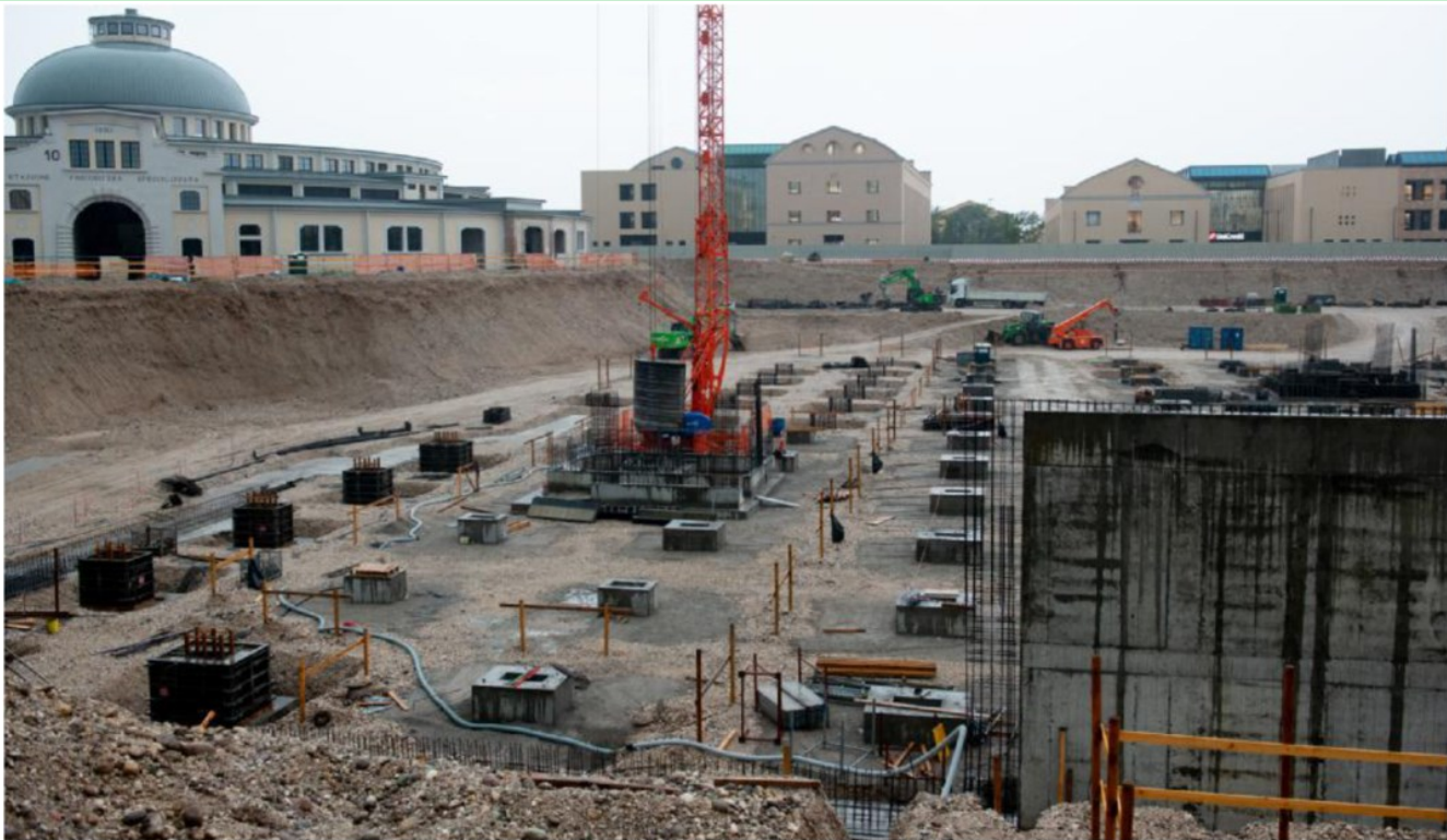
Il cantiere per il parcheggio interrato agli ex Magazzini Generali FOTO MARCHIORI
