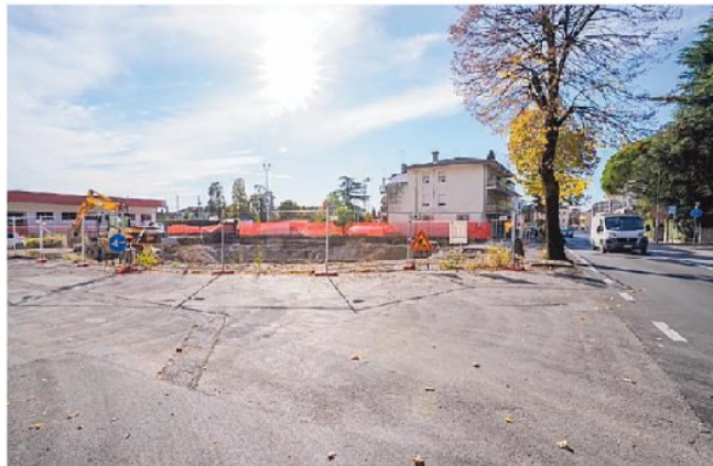
Tre immagini (quella centrale con il drone) del via ai lavori
