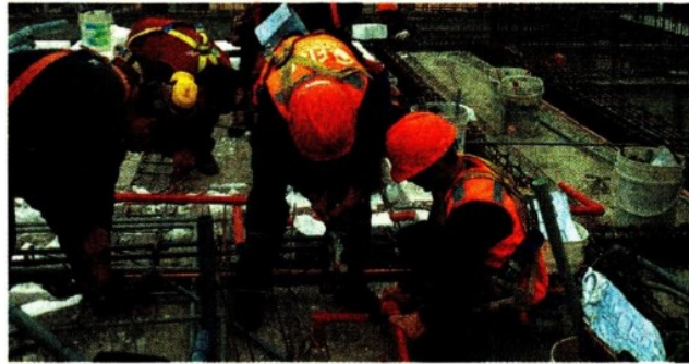
Una fase d'installazione dei prodotti Plastica Alfa
