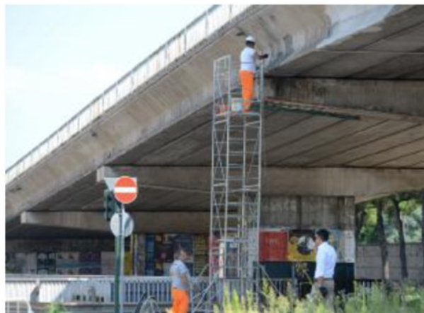
I lavori di manutenzione al cavalcavia di viale Piave a fine agosto
