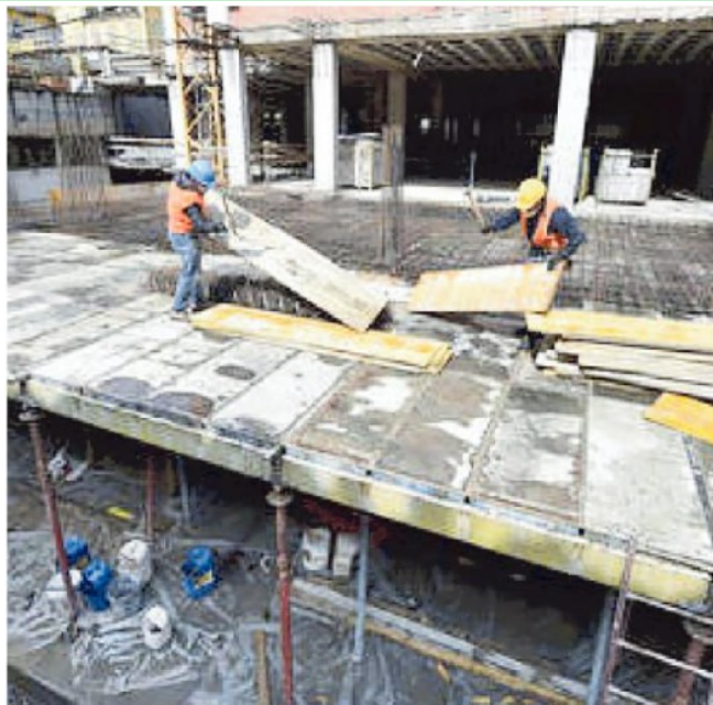
Un cantiere edile
