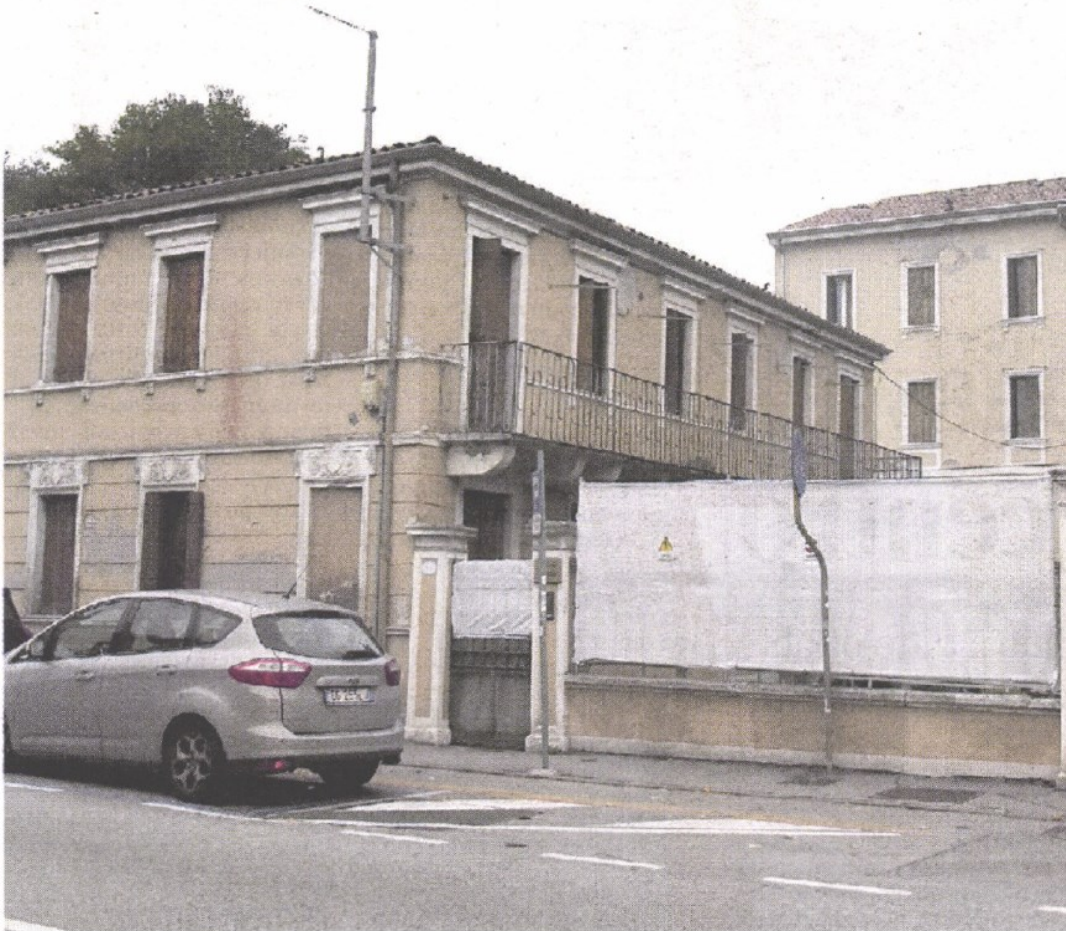
CANTIERE AL VIA Residence a cinque stelle al posto della vecchia clinica Morgagni
