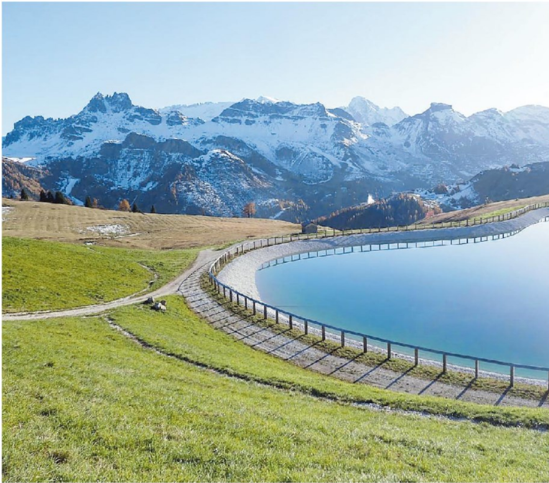
Un esempio di laghetto artificiale: il progetto realizzato ad Arabba
