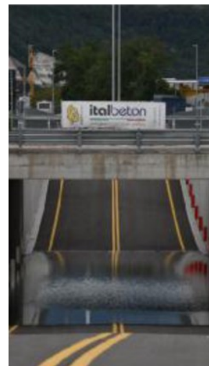
Il sottopasso a Domegliara
