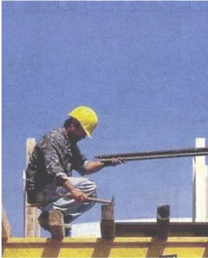
EDILIZIA Un operaio in un cantiere per il restauro di una casa; nel tondo Giampaolo Zane
