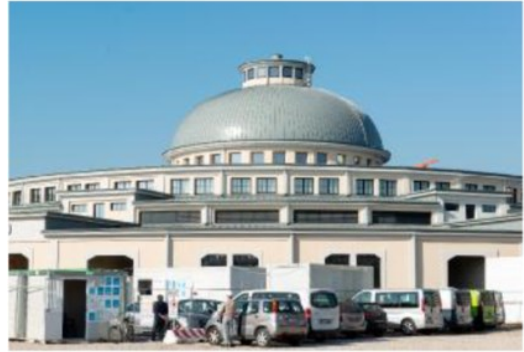
L'esterno delle ex celle frigorifere, tra le ultime opere da completare
