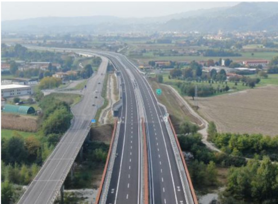
Il tratto bassanese della Pedemontana Veneta. Vicina l'apertura tra i caselli di Breganze e Bassano ovest
