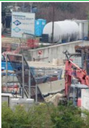
Il cantiere di San Tomio. STELLA
