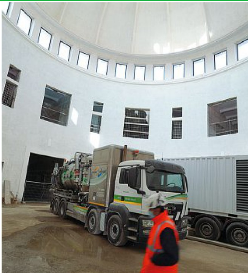
Recupero I lavori di riqualificazione agli ex Magazzini generali (Foto Sartori)
