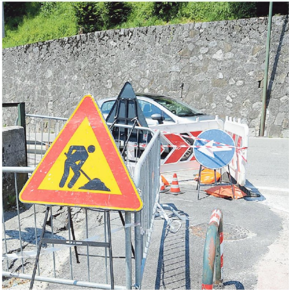
Uno dei tanti cantieri presenti lungo l'Alemagna (foto d'archivio)
