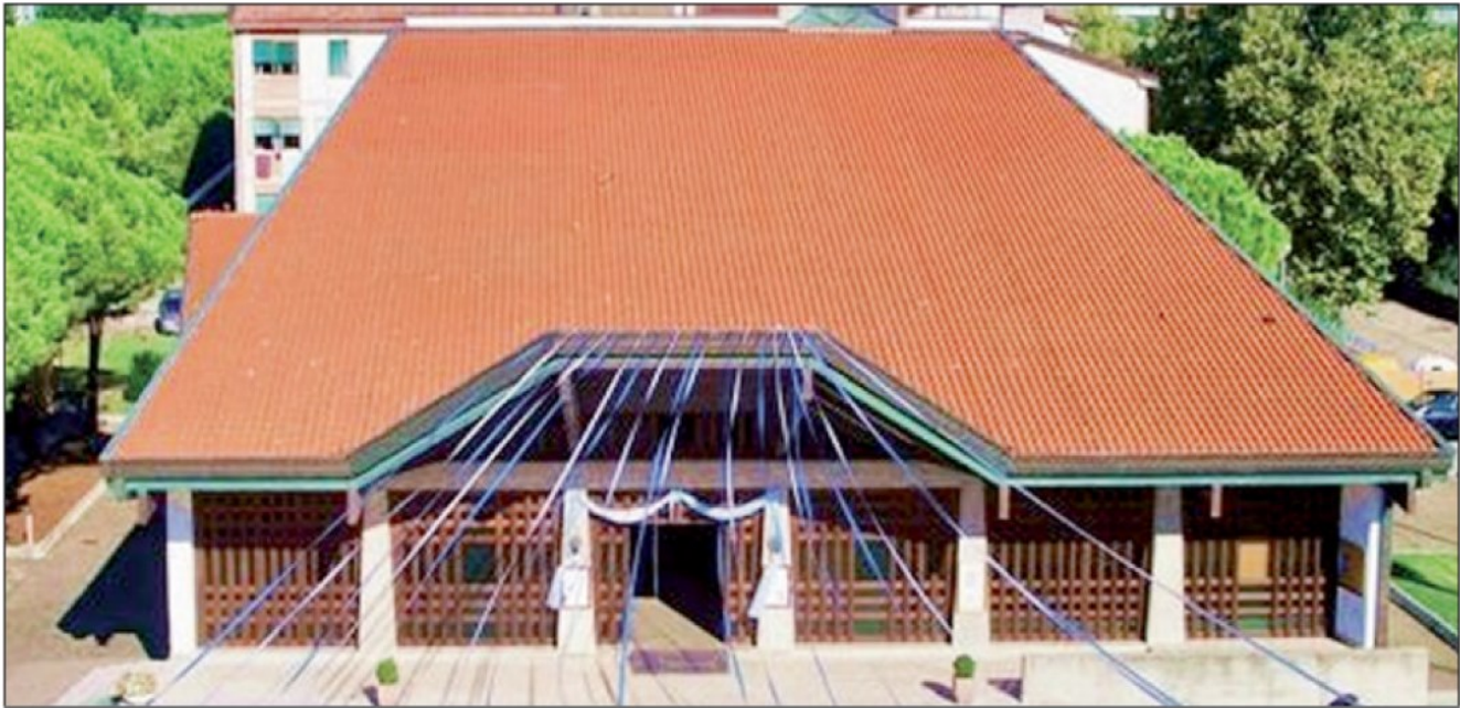
La chiesa di Santa Margherita è stata oggetto di un intervento sul tetto, per risolvere il problema delle infiltrazioni
