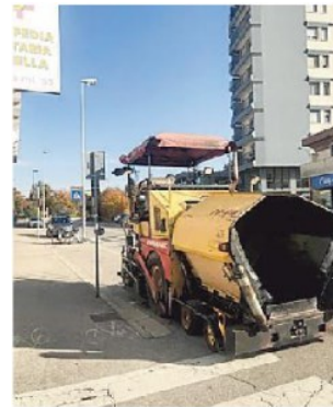
Lavori di asfaltatura
