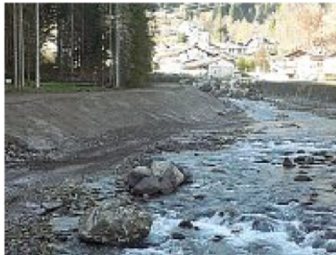
Riparazioni Un'area di lavori post-«Vaia» in Agordino
