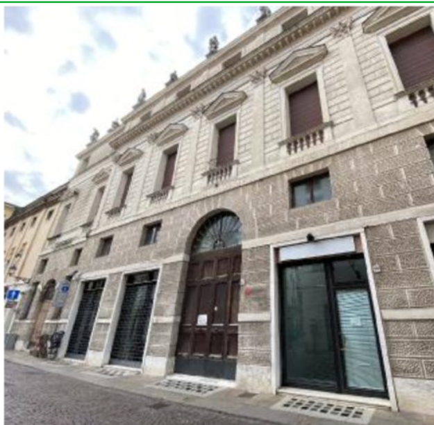
L'ex sede della Camera di commercio in corso Fogazzaro
