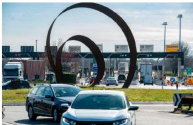
Il casello di Verona Nord sull'autostrada A22 del Brennero
