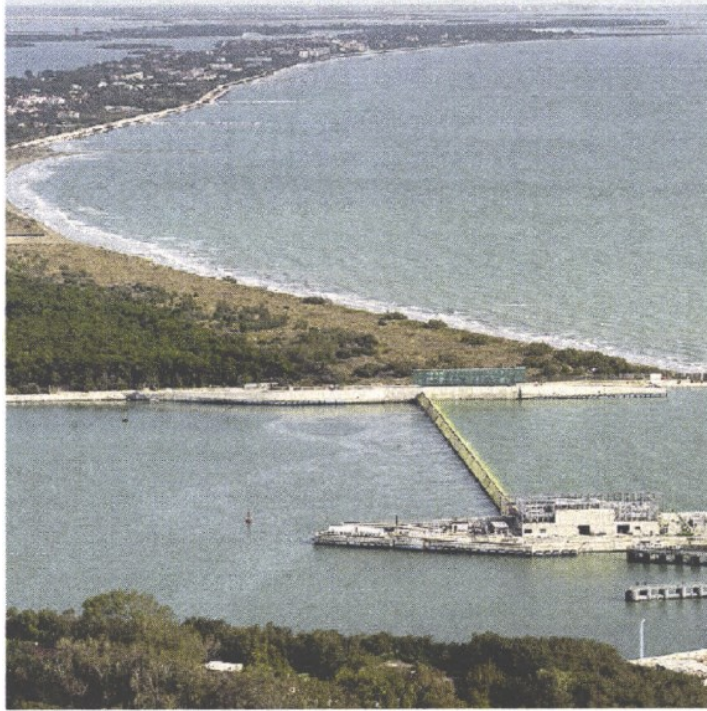
MOSE Le paratoie alzate in una delle tre bocche di porto
