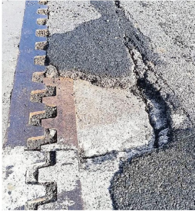
Il giunto rotto che ha costretto Veneto Strade a intervenire
