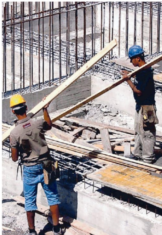
Operai al lavoro in un cantiere edile
