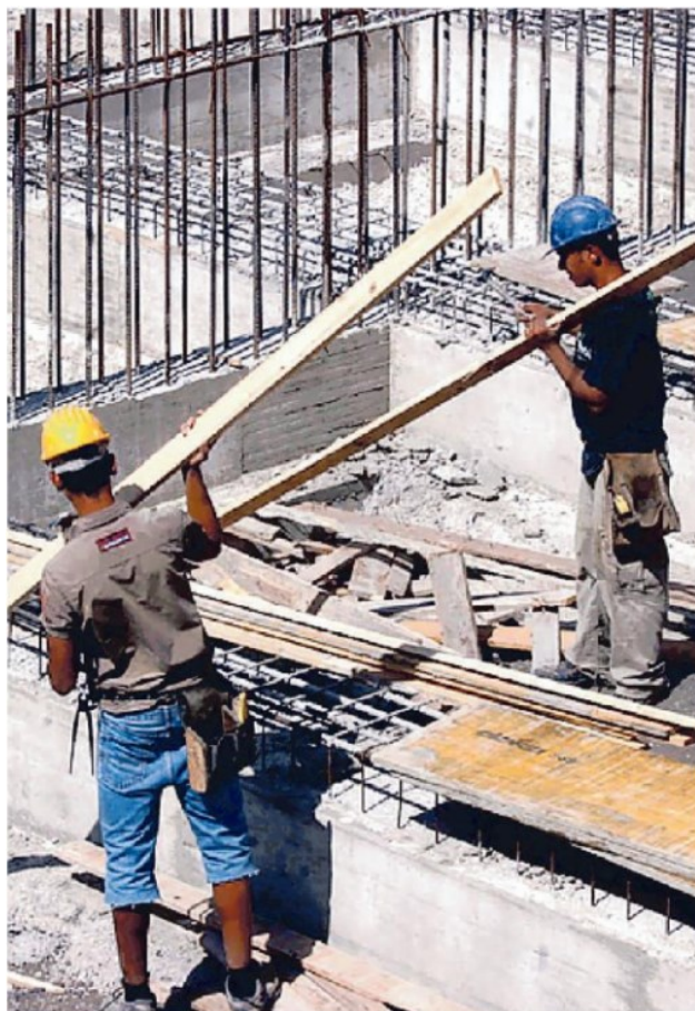
Operai al lavoro in un cantiere edile
