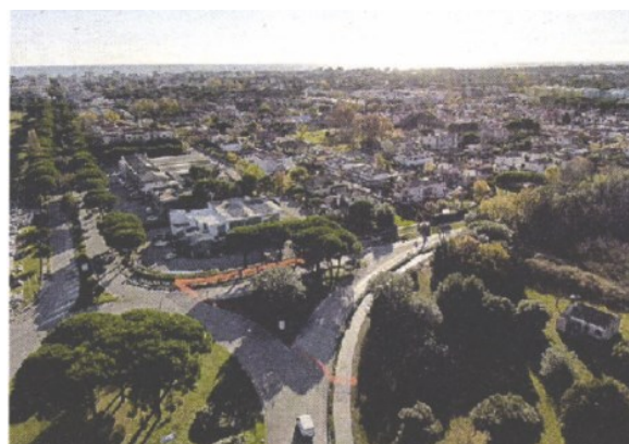
SAN MICHELE Il piano d'azione di una delle zone interessate dai lavori di queste settimane
