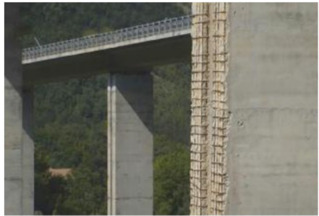
Uno dei viadotti sull'A24-A25 finiti al centro dell'inchiesta
