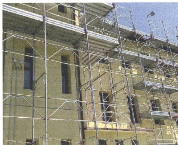
PORTOGRUARO Villa Martinelli in fase di restauro
